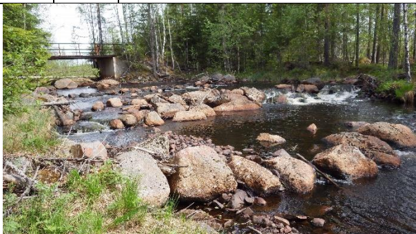
Den partiellt utrivna Bäckvallsdammen och byggda trösklar.
