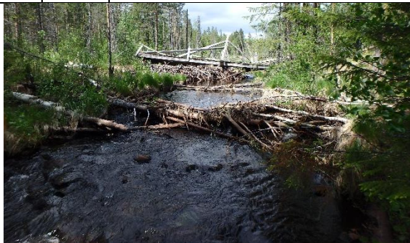
Inledningen av sträckan och en raserad bro.
