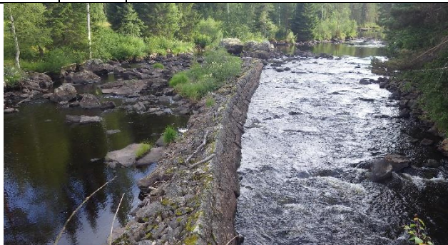
Övre delen av sträckan, tvådelad av stenkista.
