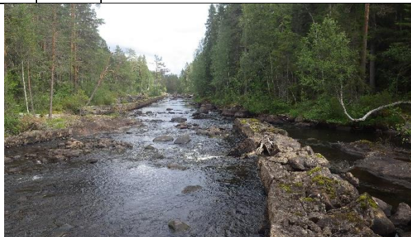
Söndersprängd ström med ledkistor på sidorna.
