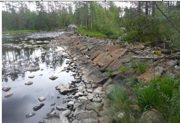
Delar av en ledarm som ev. öppnas partiellt.
