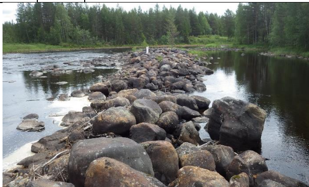
Dåligt öppnad stenvall i början av sträckan.
