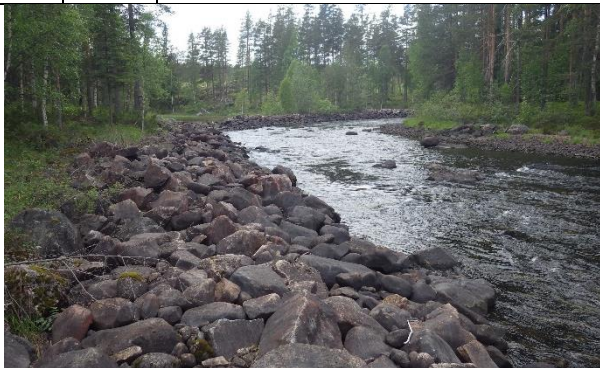
Lång schaktvall i Krokströmmens övre del.
