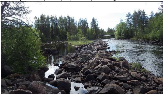
Schaktvall som isolerar halva älvens bredd.
