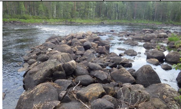
Upplagd pir som rivs bort i sträckans nedre del
