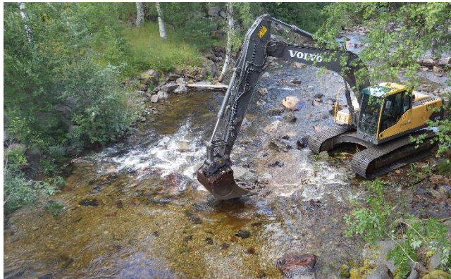
Exempel på anläggning av en lekbotten med lekgrus utkört via markmaskiner (Ljusdal Energi AB), Våljeån 2016.
