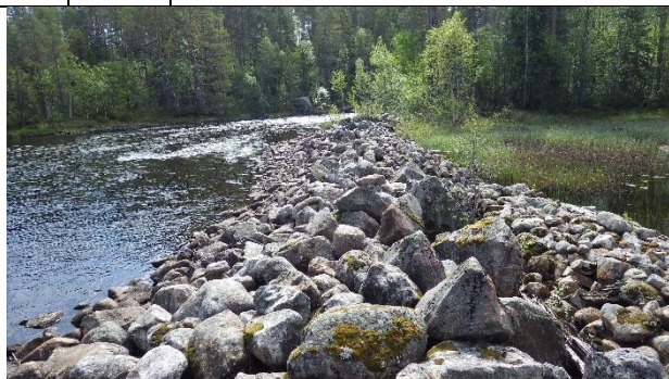
Enorm stenvall som styr in vattnet i Rullbokanalen.
