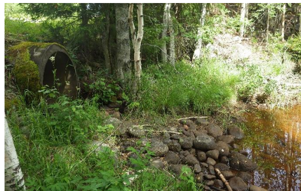
Vägtrumma ur funktion på grund av dess höjdläge.
