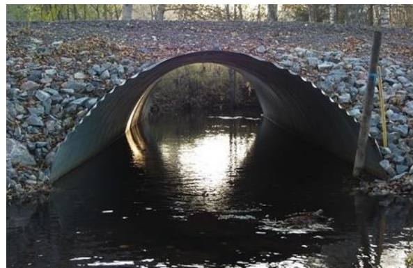
Exempel på valvbågesbro, Östbyån Söderhamns kommun.
