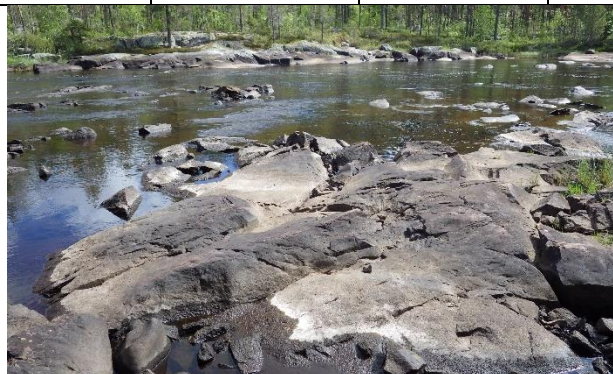
Sprängskadade hållar i mittdelen av sträckan.
