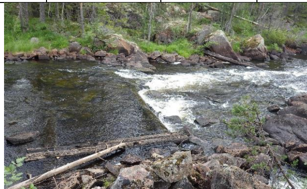
Dammrest och rensvallar i slutet av sträckan.
