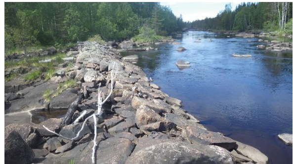
Murad stenlista i Voxnan/N om Björnbokojan (str. 7): Öppnas närmast land, men eftersom den har ett något "slarvigt" utförande helst helt.
