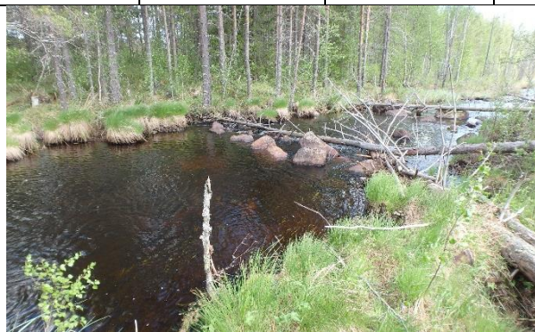
Utlagda blocktrösklar nedströms dammen (foto Bertil Nääs).
