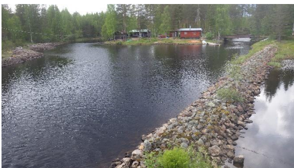
Avskärmande rensvall i Voxnan (str. 1), ovan landsväg Rullbo: Kan bevaras med tanke på redan artificiell miljö.
