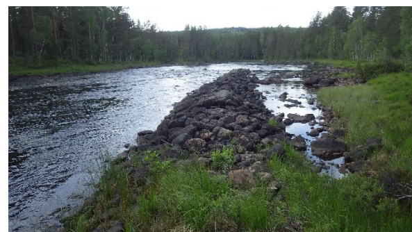
Avskärmande rensvall i Voxnan/V om Kvarnberg: När det gäller lämningar som dessa i mer otillgängliga miljöer bör en fullständig utrivning vara ett krav.
