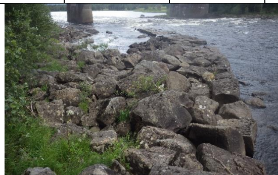
Längre ledarm med "löst material" närmast land.
