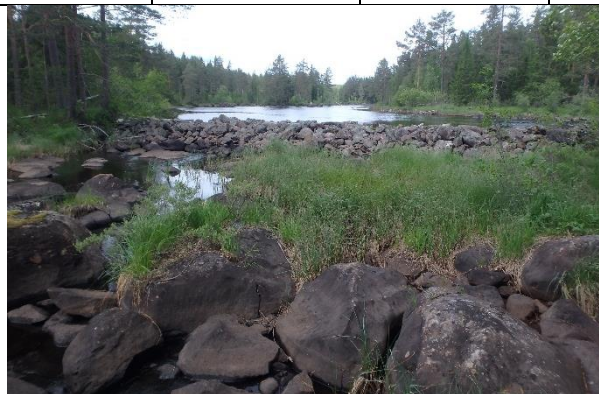
Sidofåra avskild av en stenvall i slutet av sträckan.
