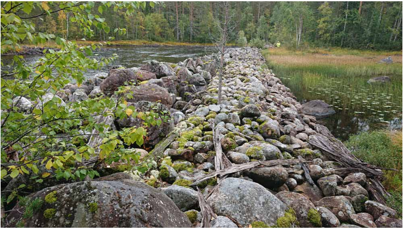
Lämning 2_5, L2020:9396. Stenkista, ställvis synlig träkonstruktion, ca 50 m l (NÖ-SV), 6 m br och 1,5 m h, av 0,3–1 m st stenar. I vallen syns rikligt med raserat timmer från träkonstruktion. Stänger av ett biflöde SSV om huvudfåran. På lämningen renssten. Kulturvärde: Röd
