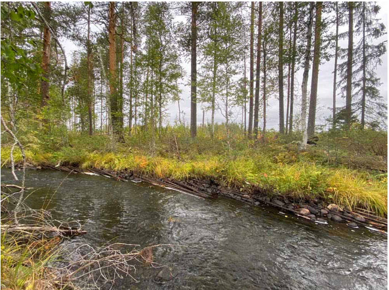
Lämning J2_3, L2020:9365. Strandskoning, ca 50 m l (N-S), bestående av störrar, ca 3 m l och 0,05-0,07 m diam. Vid fältbesöket var 1-5 skift synliga. Kulturvärde: Gul
