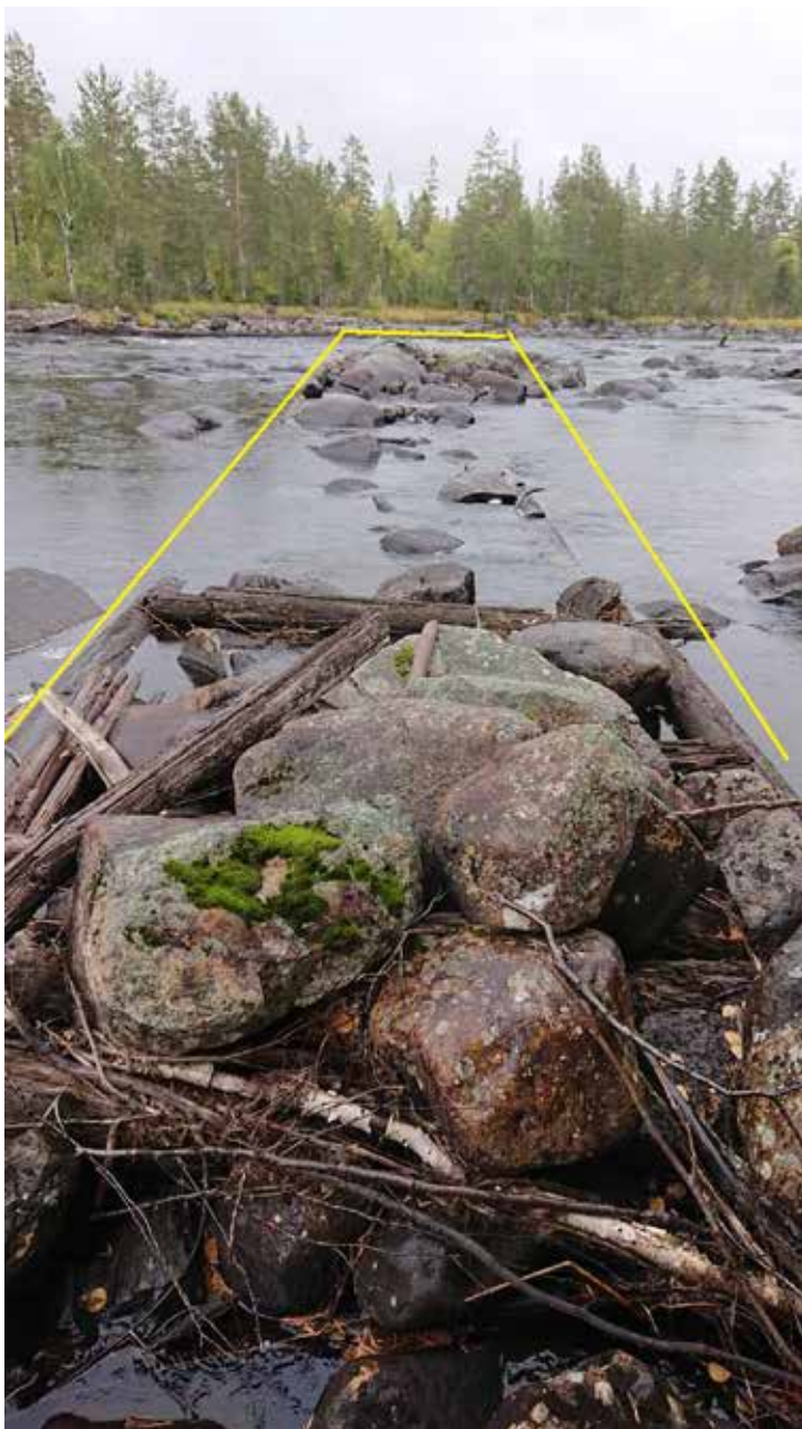
Lämning 3_4, L2020:9405. Ledarm, med synlig träkonstruktion, ca 25 m l (Ö-V), 3 m br och 0,5–0,6 m h, av 0,4–1 m st stenar. Delvis raserad. Kulturvärde: Gul
