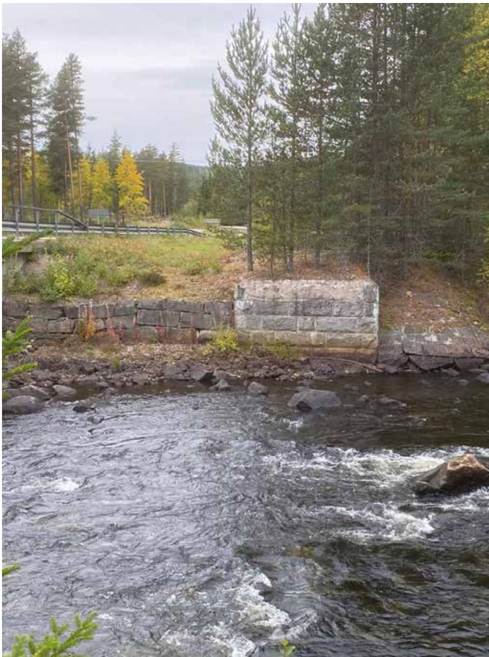
Lämning 10_2, L2020:9435. Brofäste, ca 4–4,5 m br och ca 4 m h. Av huggna stenblock, 0,7–1,2x0,5–1,3 m st. Ansluter till befintligt brofäste. På ömse sidor om älven. Kulturvärde: Gul
