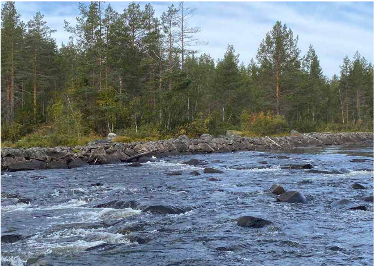
Lämning 8_3, L2020:9430. Ledarm, med synlig träkonstruktion, ca 40 m l (NNÖ-SSV), ca 3 m br och 1,5 m h. Vid fältbesöket 1 stockvarv synligt. Uppbyggd av 0,2–1,5 m st stenar. Huggna och tätt lagd mot älvfåran. Stänger av biflöde i V. Kulturvärde: Röd
