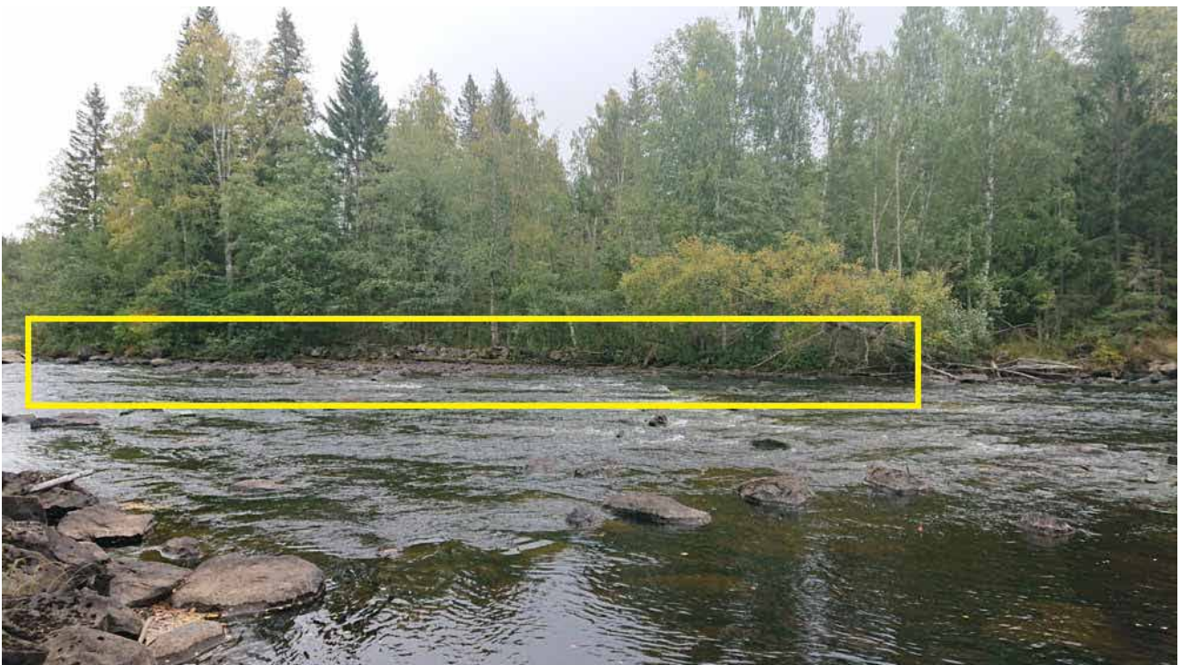
Lämning 26_3, L2020:9536. Strandskoning, med synlig träkonstruktion, ca 50 m l (NÖ-SV), 3 m br och 0,4–0,5 m h. Vid fältbesöket var 1–2 stockvarv synliga. Uppbyggd av 0,2–0,5 m st stenar. Beväxt med lövsly. Kulturvärde: Gul
