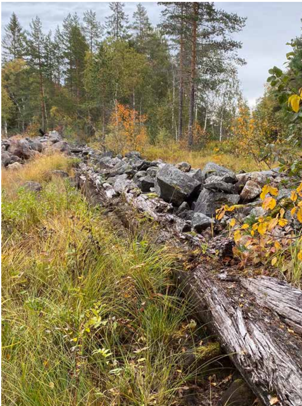
Lämning 18_1, L2020:9469. Stenkista, med synlig träkonstruktion, ca 60 m l (NV-SÖ), ca 4 m br och 0,7–0,8 m h. Vid fältbesöket var i 2–3 stockvarv synliga. Uppbyggd av 0,2–1 m st stenar. Stänger av biflöde S om huvudfäran. S om kistan finns rikligt med renssten i vall. Kulturvärde: Röd
