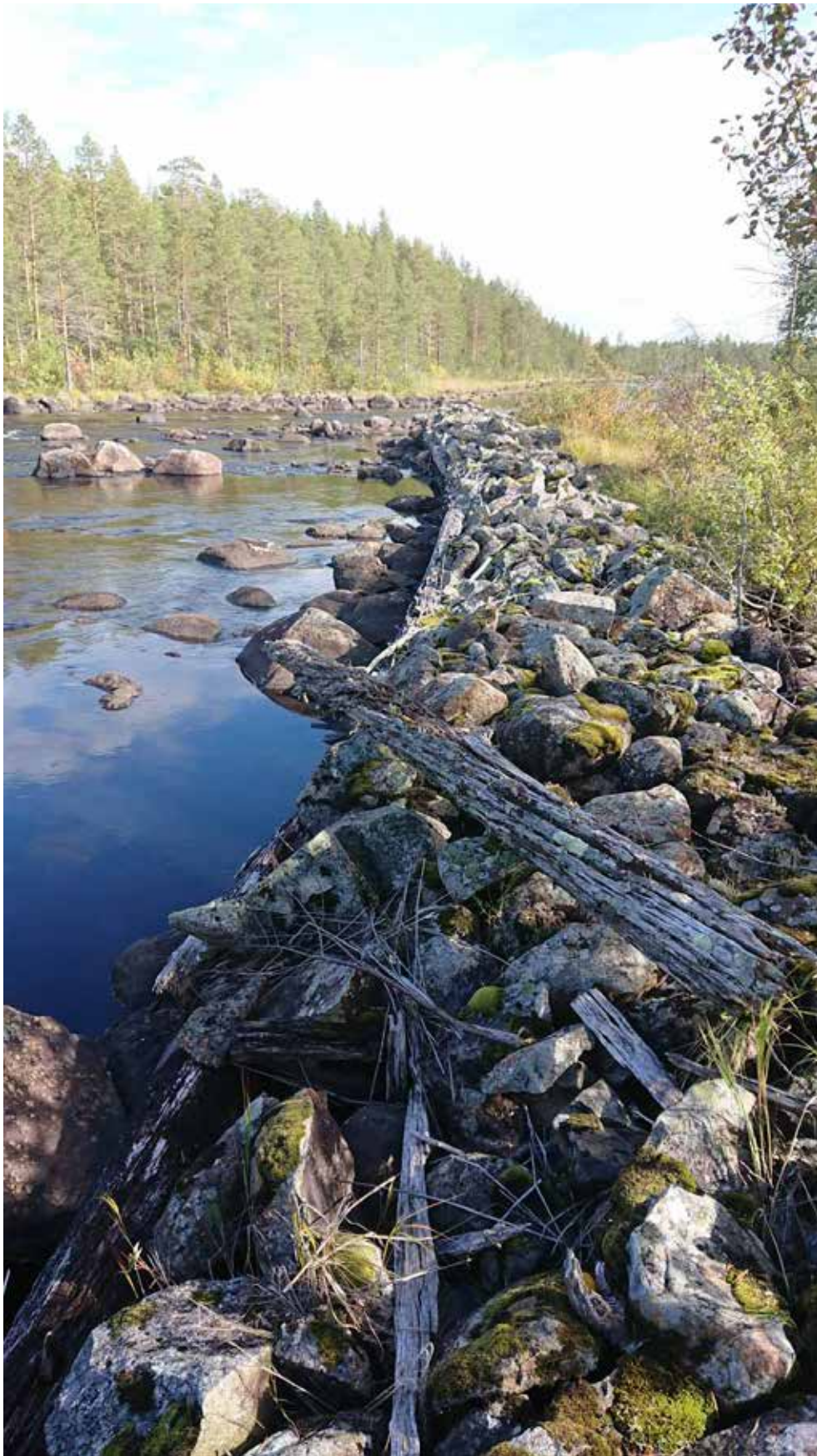
Lämning 1_1, L2020:9376. Strandskoning, med synlig träkonstruktion, ca 50 m l (Ö-V), 2–3 m br och 0,5–1 m h, uppbyggd av 0,2–0,7 m st stenar. Vid fältbesöket var 1–2 stockvarv synliga. Kulturvärde: Röd
