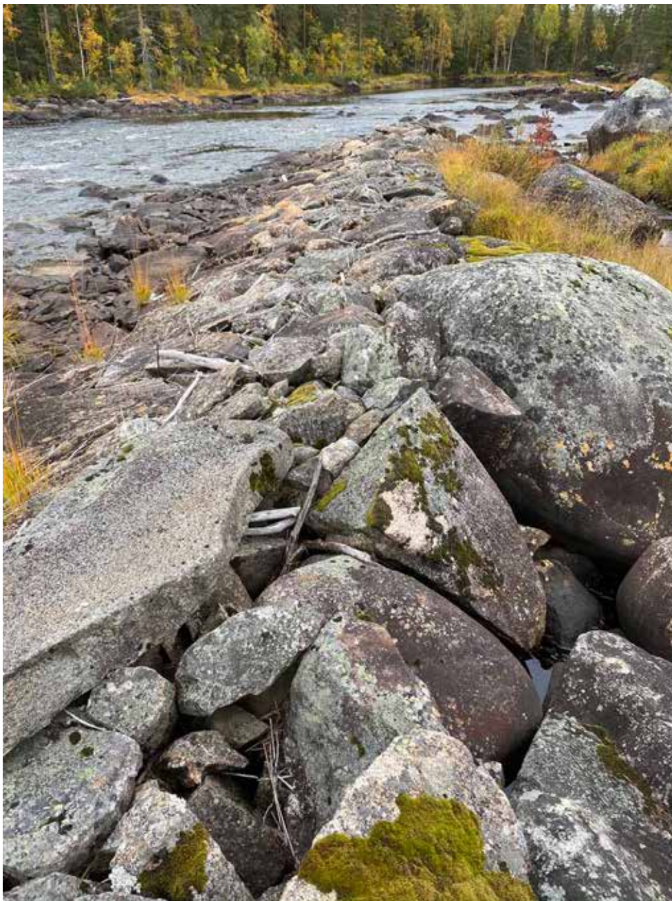
Lämning 15_6, L2020:9459. Ledarm, med ställvis synlig träkonstruktion, ca 30 m l (N-S), 2–3 m br och 1,0 m h. Uppbyggd av 0,2–0,7 m st stenar. Vällagd. Kulturvärde: Röd
