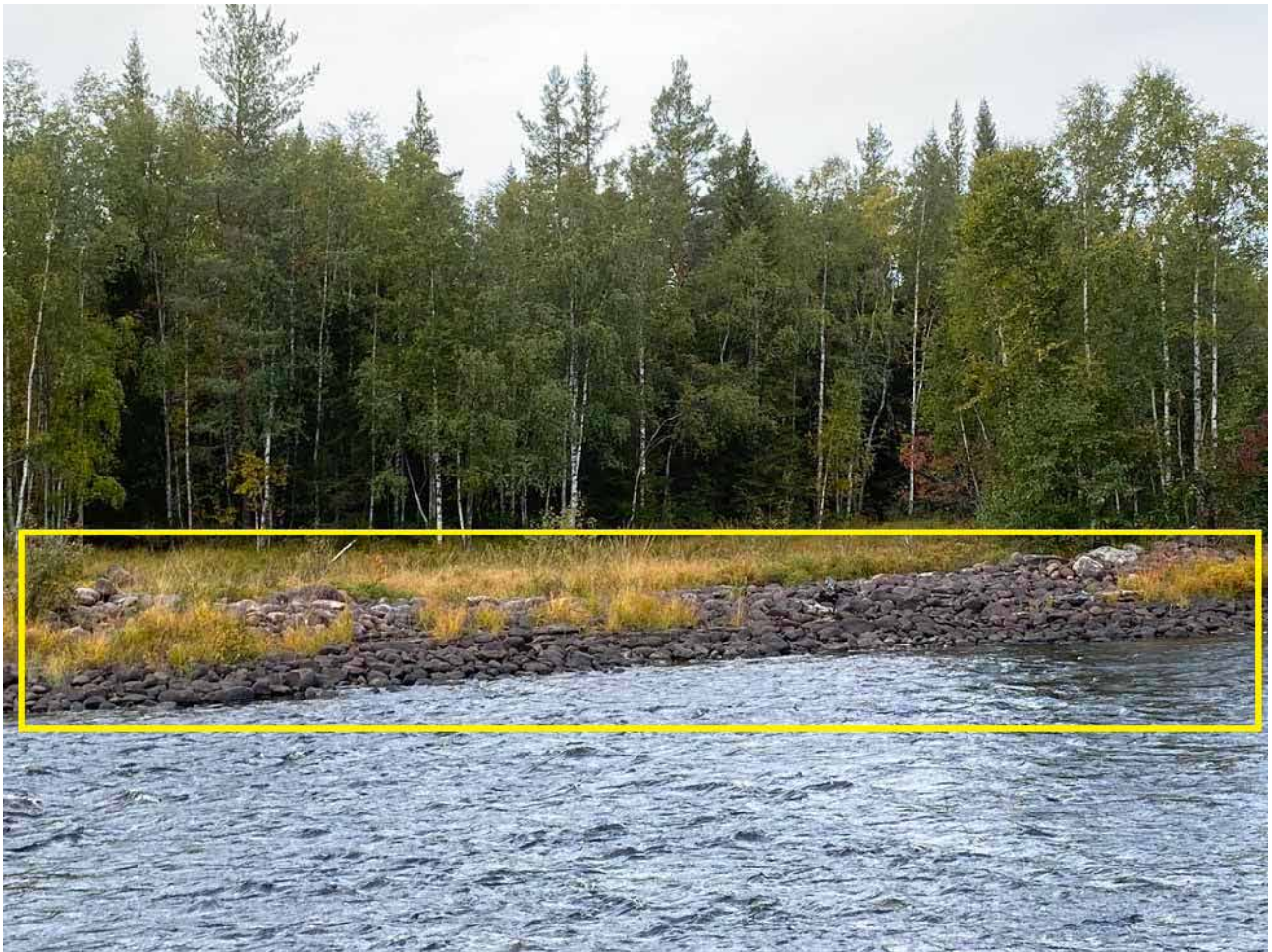
Lämning 19_2, L2020:9472. Ledarm, med ställvis synlig träkonstruktion, ca 90 m l (N-S), 2–3 m br och 1 m h. Vid fältbesöket var 1 stockvarv synligt. Uppbyggd av 0,1–0,5 m st stenar. Kulturvärde: Gul
