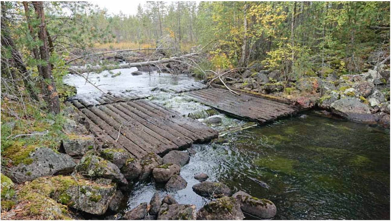
Lämning J1_2, L2020:9345. Stötbotten, 6x5 m (NÖ-SV), bestående av en timrad träkonstruktion sammanfogad med grova bultar. Centralt i lämningen saknas delar av konstruktionen. Kulturvärde: Röd
