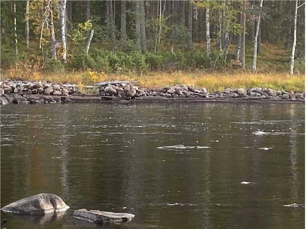
Lämning 16_1, L2020:9460. Stenkista, med synlig träkonstruktion, ca 30 m l (Ö-V), ca 3,5 m br och 0,5 m h. Vid fältbesöket var 1–2 stockvarv synliga. Uppbyggd av 0,1–0,5 m st stenar. Övergår i V till vall av rensten. Stänger av biflöde. Kulturvärde: Gul
