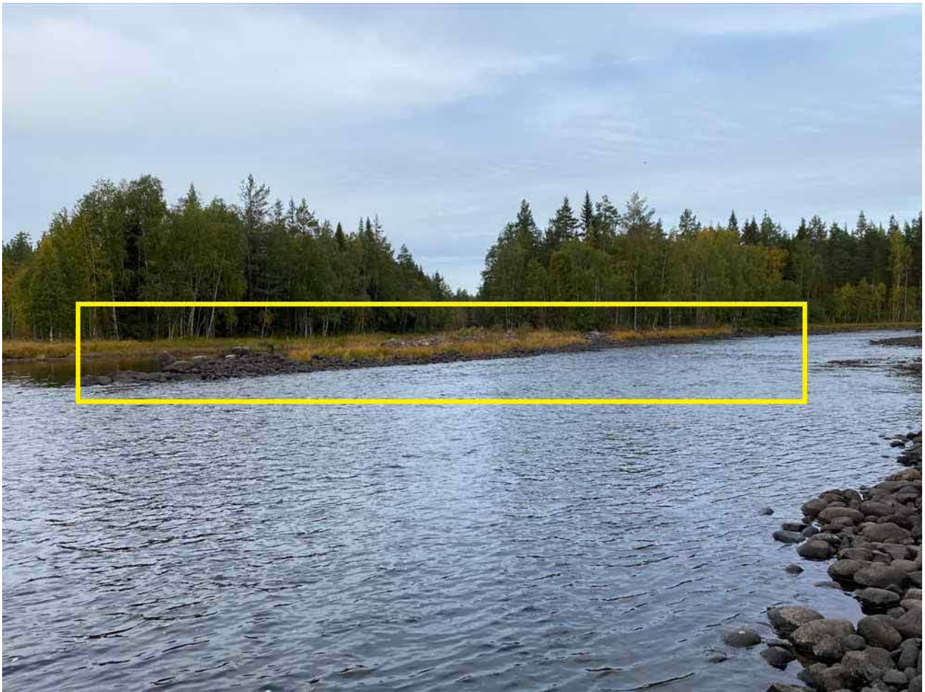
Lämning 19_3, L2020:9473. Ledarm, med synlig träkonstruktion, raserad. Icke mätbar höjd och bredd. Vid fältbesöket ett stockvarv ställvis synligt. Ligger i älvfåran. Kulturvärde: Gul
