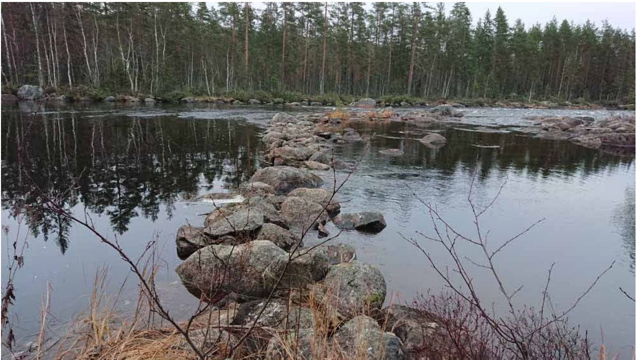
Lämning 15_2, L2020:9455. Ledarm, ca 55 m l (N-S), 4 m br och 1 m h, delvis med synlig träkonstruktion i den N delen, därefter vällagd stenvall. Vid fältbesöket var 1–2 stockvarv synliga. Uppbyggd av 0,2–0,7 m st stenar. Kulturvärde: Röd
