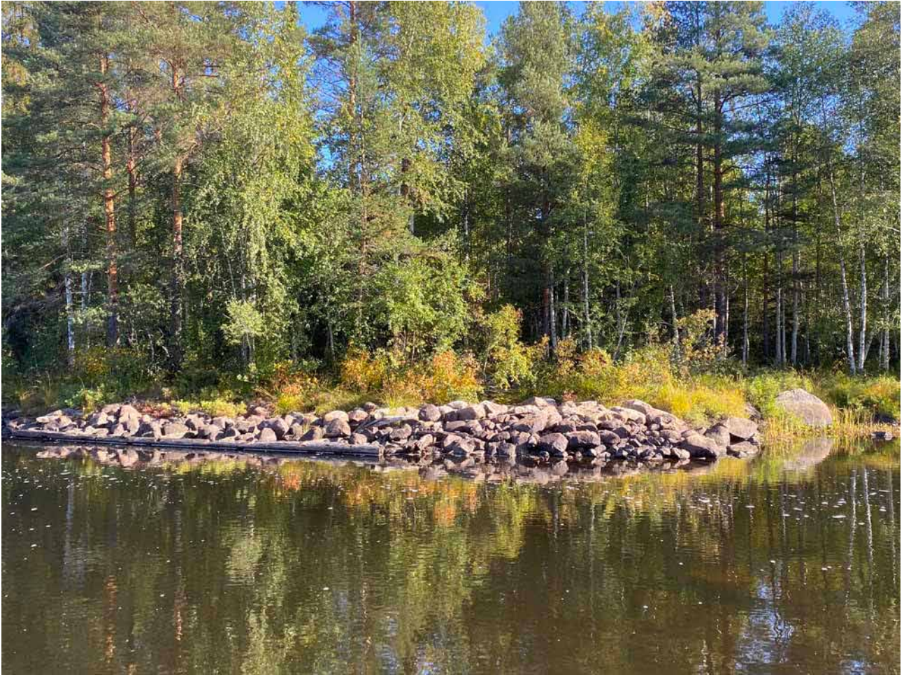
Lämning 14_3, L2020:9446. Strandskoning med synlig träkonstruktion, ca 25 m l (NÖ-SV), 3–4 m br och 0,5 m h. Vid fältbesöket 1 stockvarv synligt. Uppbyggt av 0,4–1,2 m st stenar. Kulturvärde: Gul
