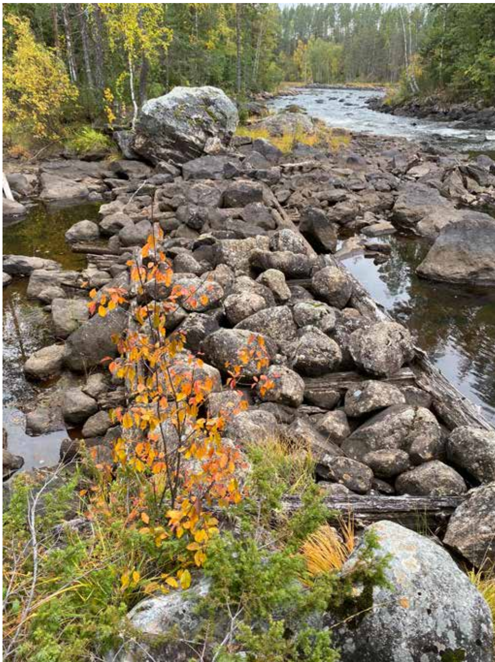
Lämning 20_6, L2020:9516. Stenkista, med synlig träkonstruktion, ca 15 m l (NNV-SSÖ), 3 m br och 0,4–0,6 m h. Vid fältbesöket var ställvis 1–2 stockvarv synliga. Uppbyggd av 0,3–1,2 m st stenar. Stänger av biflöde till V om huvudfåran. Kulturvärde: Röd
