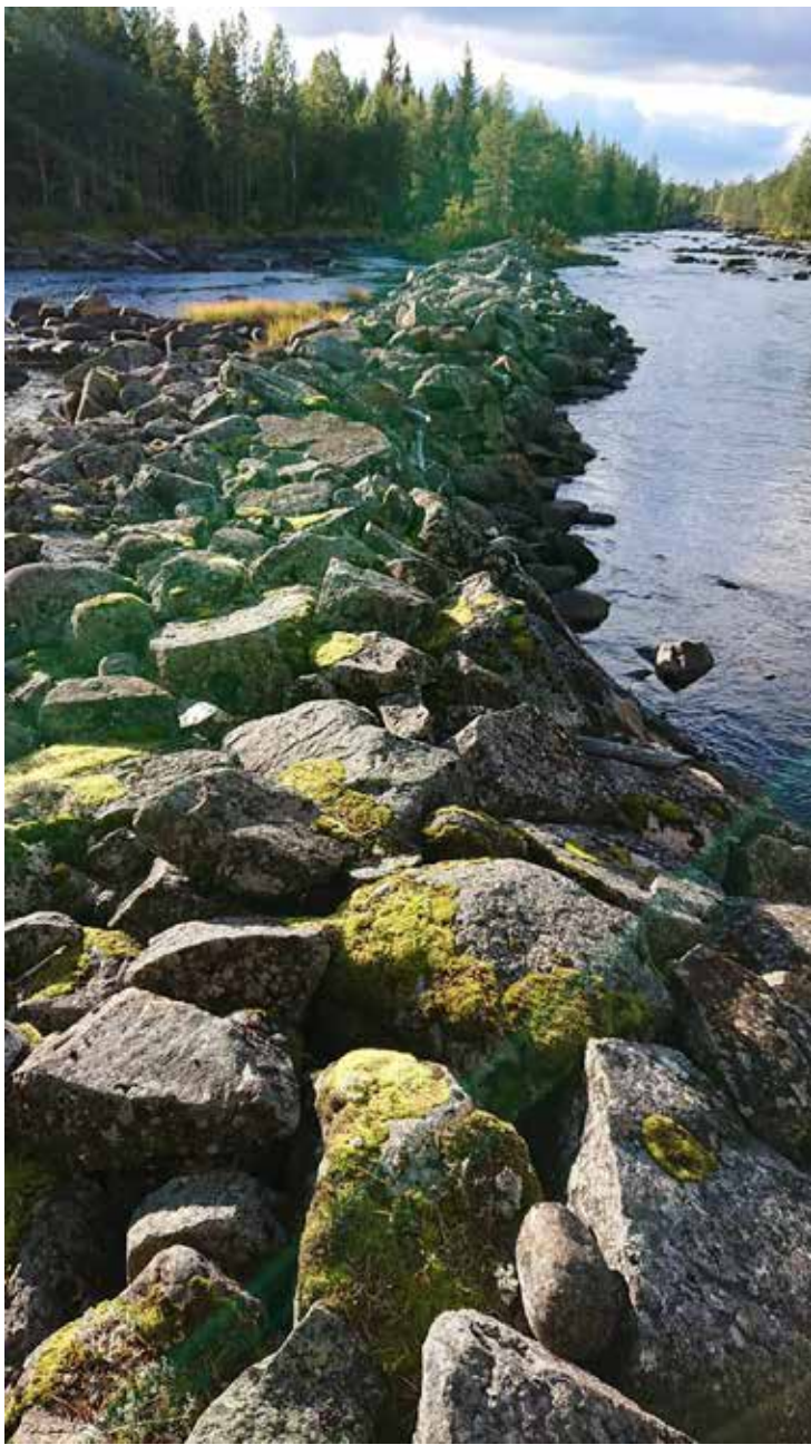
Lämning 7_1, L2020:9420. Ledarm, utan synlig träkonstruktion, ca 100 m l (Ö-V), 2–3 m br och 1,5 m h, av 0,5–1,2 m st stenar. Ställvis vällagd. Kulturvärde: Gul
