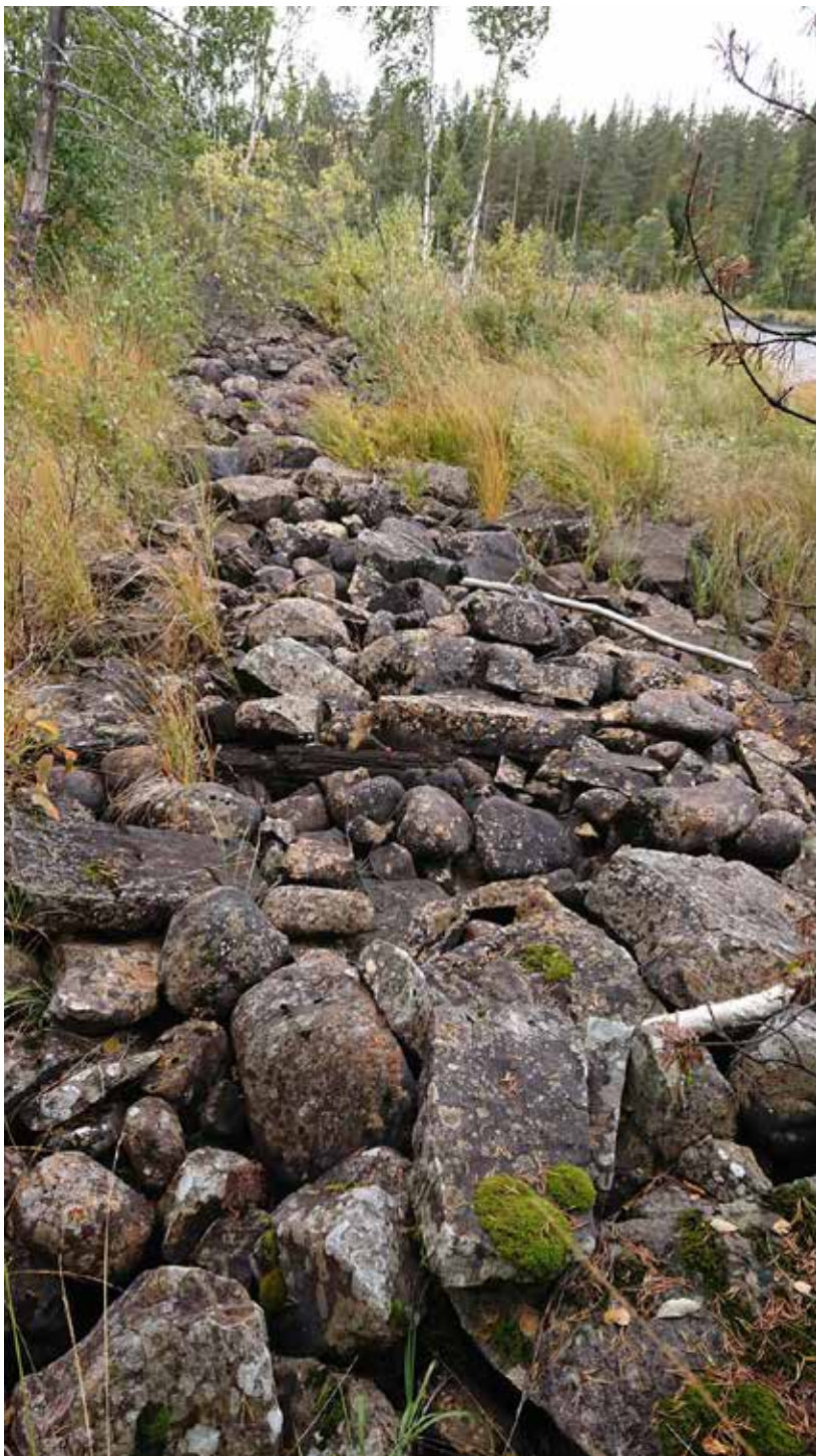
Lämning 5E_1, L2020:9415. Stenkista, med ställvis synlig träkonstruktion, ca 70 m l (N-S), 2–3 m br och 0,2–0,4 m h. Vid fältbesöket var 1 stockvarv synligt. Uppbyggd av 0,1–1 m stenar. Stenkistans mitt är raserad, på en sträcka av ca 1 m. Stänger av biflöde Ö om huvudfåran. På stranden i N delen av kistan ett tiotal förmultnade länsar. Kulturvärde: Gul
