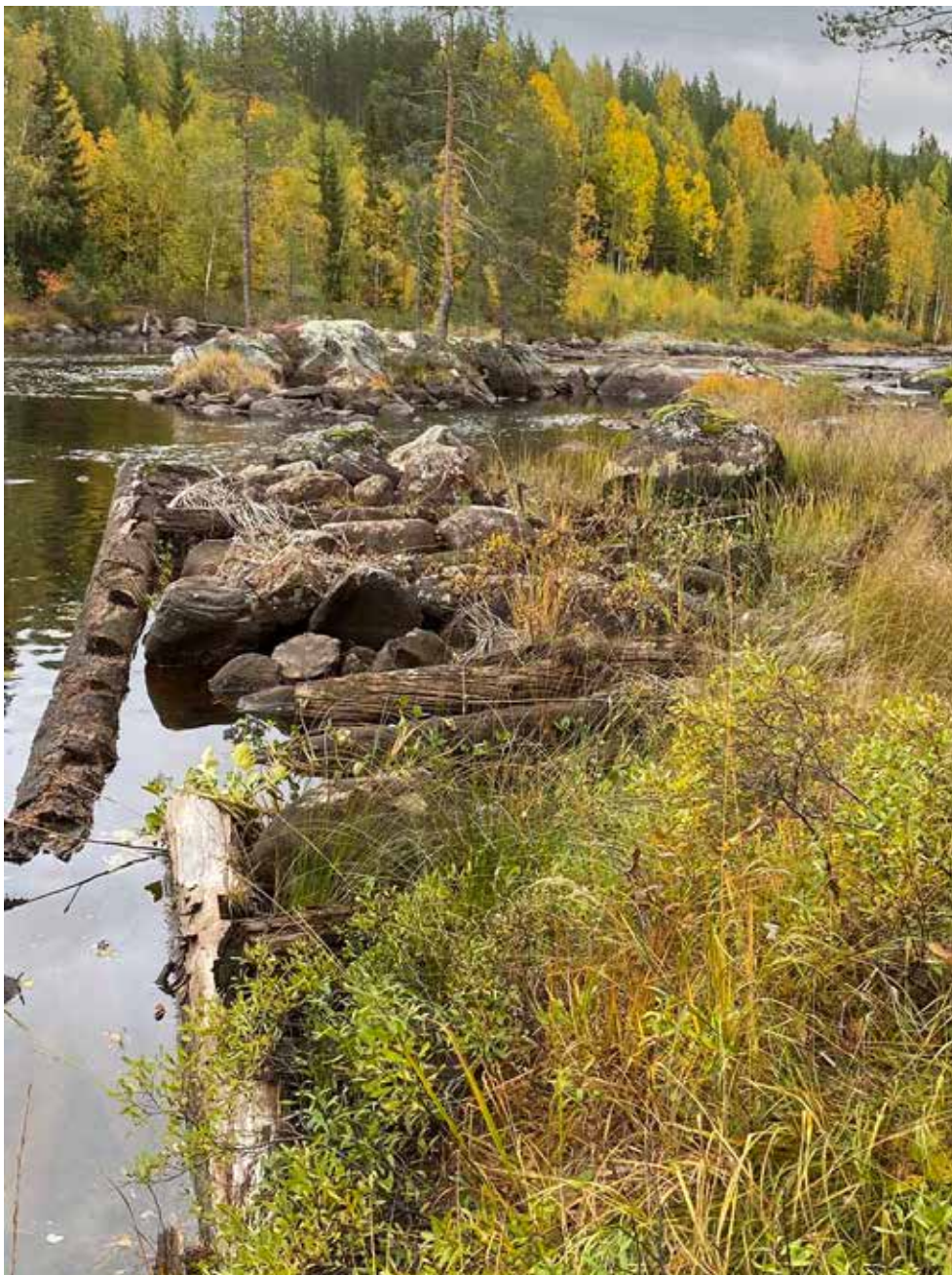
Lämning 15_1, L2020:9453. Stenkista, med synlig träkonstruktion, ca 30 m l (ÖNÖ-VSV), 4 m br och 0,5 m h. Vid fältbesöket var 1–2 stockvarv synliga. Uppbyggd av 0,3–1 m st stenar. Stockar vid strandkanten. Kulturvärde: Gul
