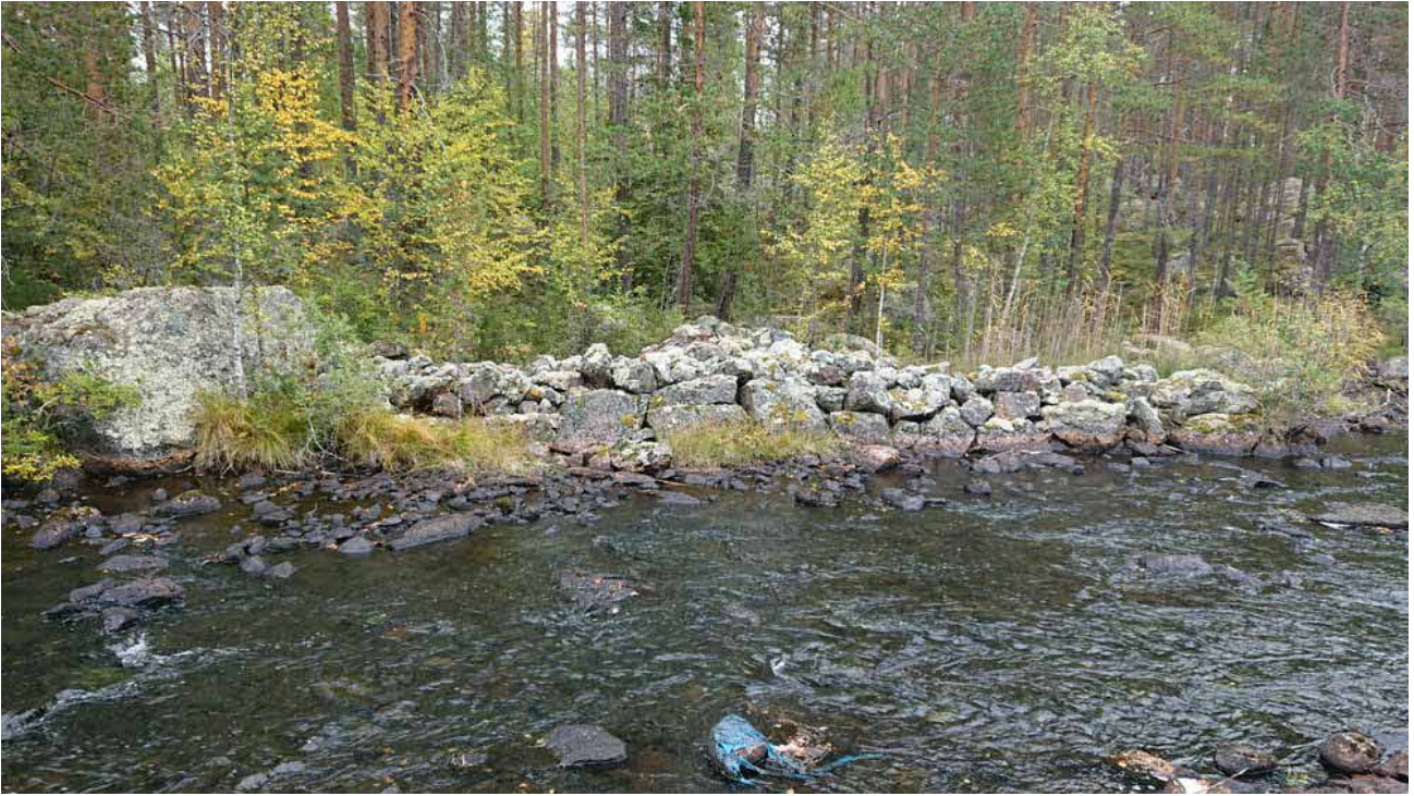
Lämning J1_7, L2020:9359. Strandskoning, utan synlig träkonstruktion, ca 45 m l (NV-SÖ), 1,5–2 m br och 0,6–0,8 m h. I NV änden mot mark fast block. Övermossad. Kulturvärde: Gul
