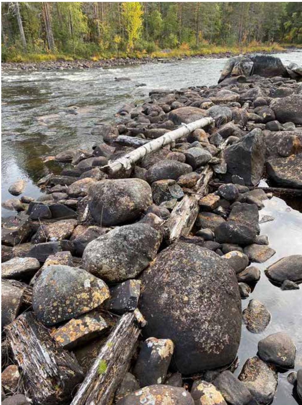
Lämning 16_2, L2020:9462. Stenkista, med synlig träkonstruktion, ca 14 m l (NNV-SSÖ), 3,5 m br och 0,5 m h. Uppbyggd av 0,2–1,2 m st stenar. Lämningen delvis raserad. Kulturvärde: Gul
