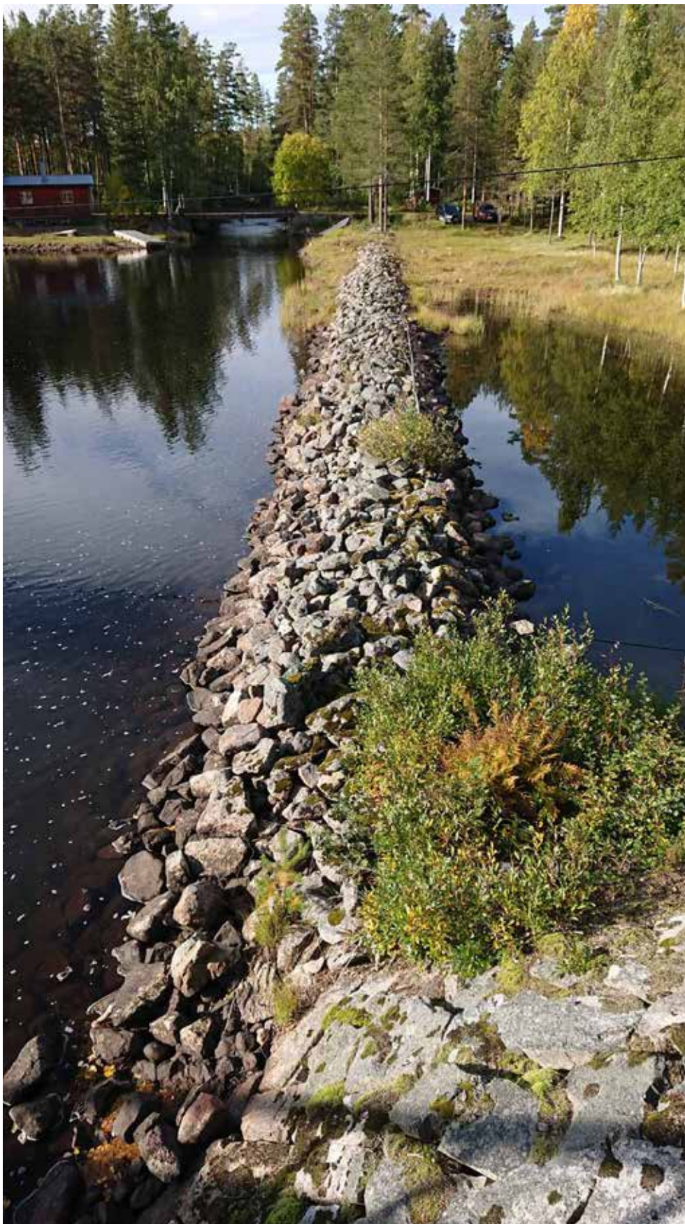
Lämning 1_7, L2020:9391. Ledarm, utan synlig träkonstruktion, ca 80 m l (NNV-SSÖ), 4 m br och 0,5–1,5 m h, av 0,3–0,7 m st stenar. Delvis raserad. Avgränsar ett lågt fuktigt område N om älvfåran. Avslutas i SÖ mot brofäste. Kulturvärde: Röd
