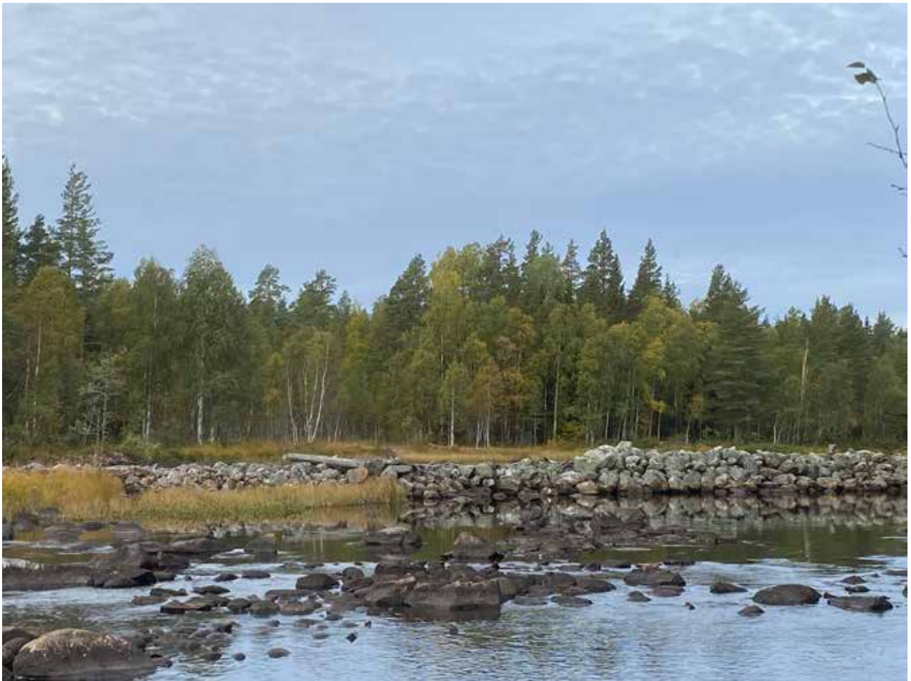
Lämning 19_1, L2020:9471. Ledarm, utan synlig träkonstruktion, ca 80 m l (N-S), 4 m br och 1,2 m h, av 0,2–1,0 m st stenar. Kulturvärde: Gul
