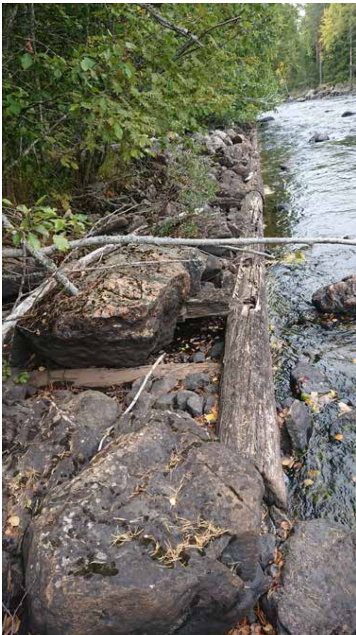
Lämning 26_1, L2020:9533. Strandskoning, med synlig träkonstruktion, ca 60 m l (ÖNÖ-VSV), 3–3,5 m br och 0,2–0,3 m h. Vid fältbesöket var 1 stockvarv synligt. Uppbyggd av 0,1–0,5 m st stenar. Enstaka lövsly på lämningen. Kulturvärde: Röd
