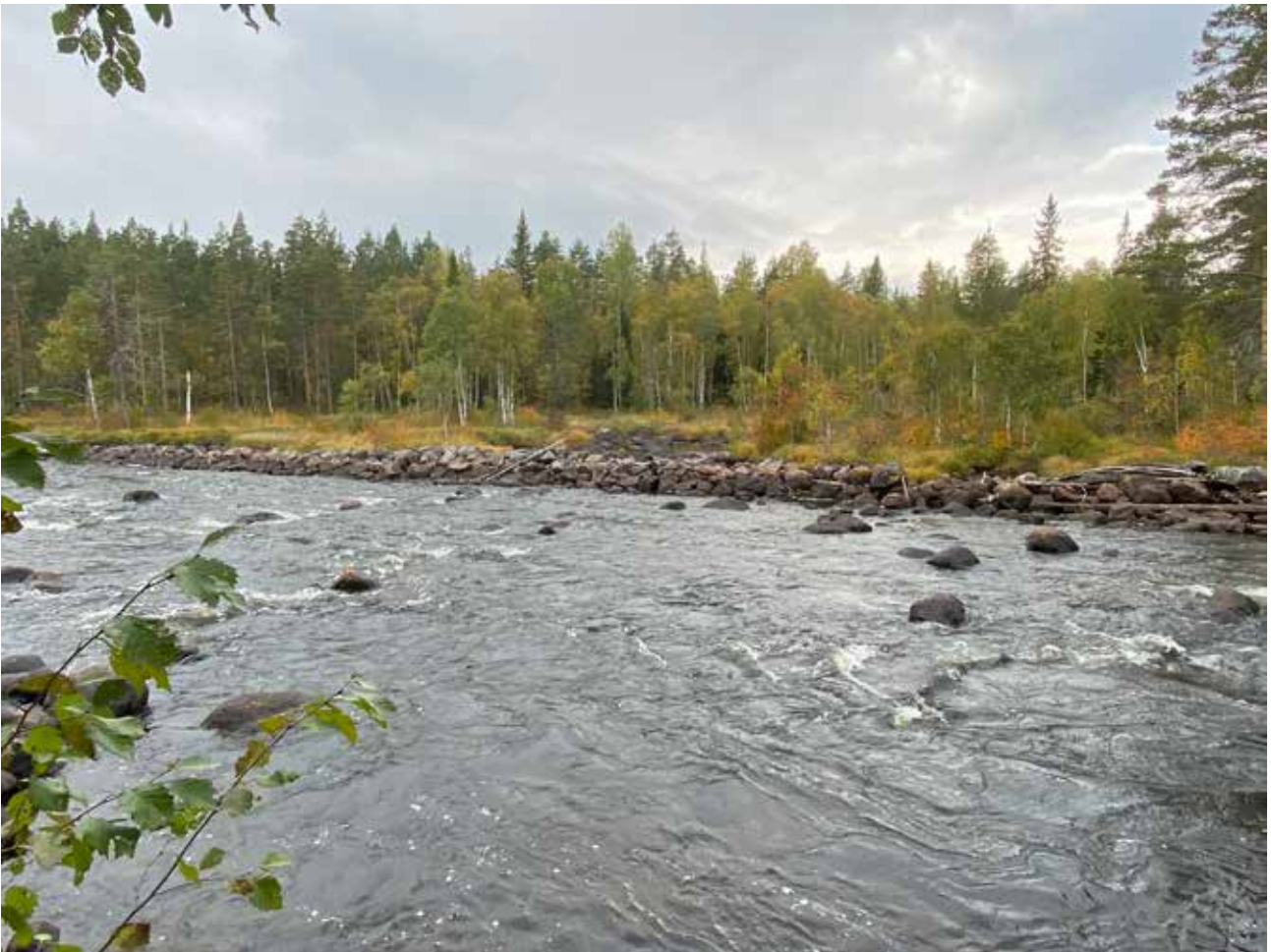
Lämning 20_7, L2020:9517. Ledarm, bågformad, med synlig träkonstruktion, ca 150 m l (N-S), 3–4 m br och 0,5–0,7 m h. Vid fältbesöket var ställvis 1–2 stockvarv synliga. Uppbyggd av 0,2–1 m st stenar. Stänger av ett biflöde på V sidan av biflöde. Kulturvärde: Röd
