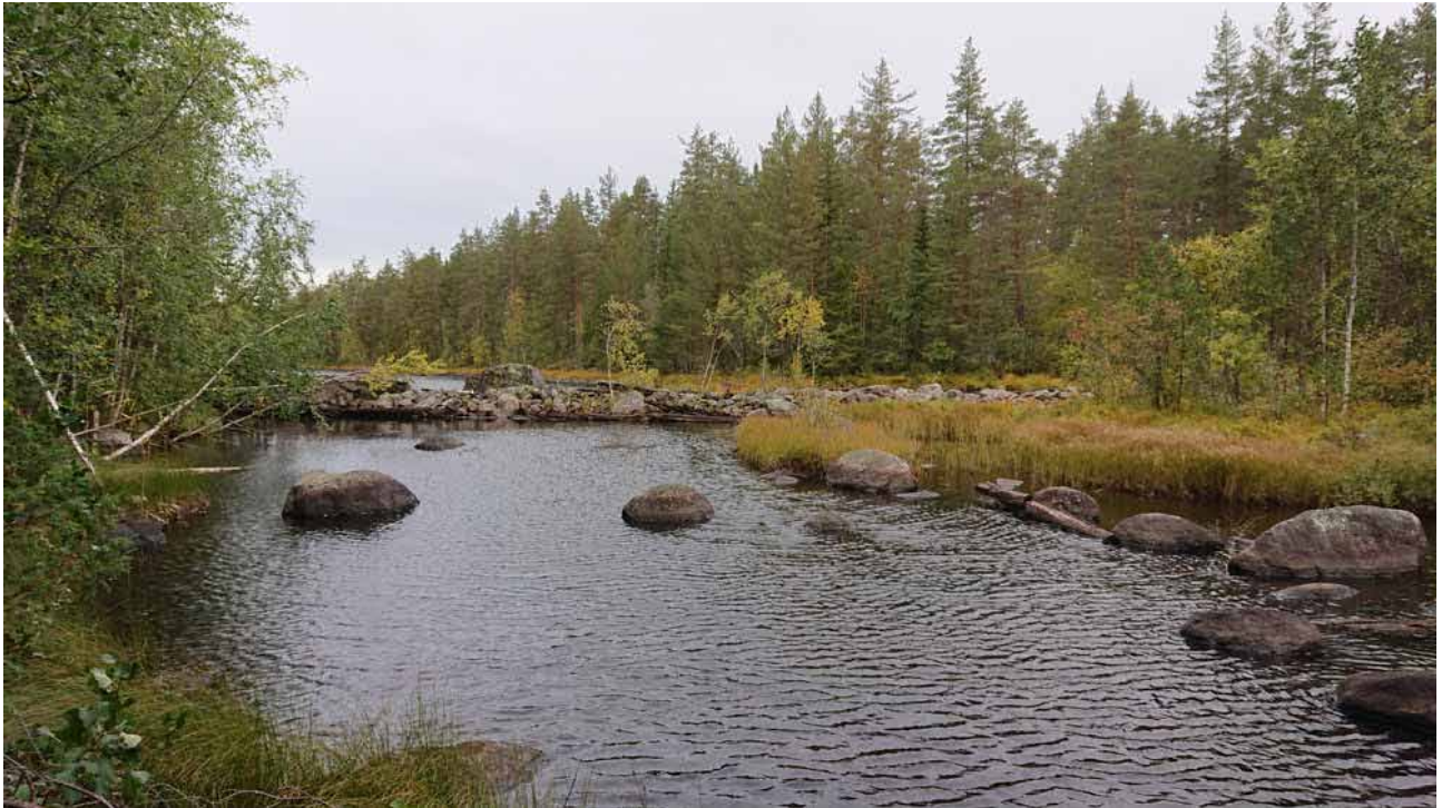
Lämning 4_1, L2020:9412. Stenkista, med synlig träkonstruktion, ca 45 m l (Ö-V), 3,5 m br och 1,5 m h. Uppbyggd av 0,5–1,5 m st stenar. Upplagd renssten på lämnigen. Kulturvärde: Röd
