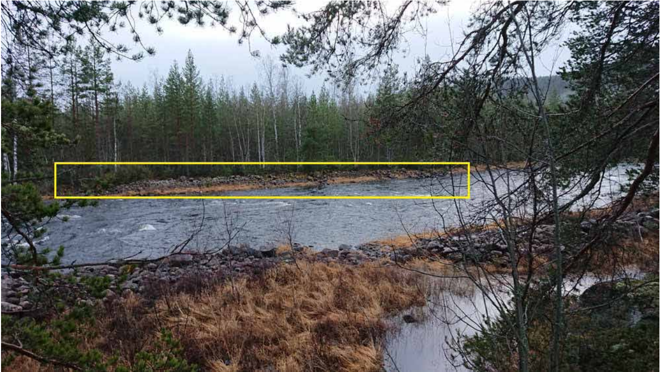
Lämning 9_127, L2020:11220. Strandskoning, utan synlig träkonstruktion, ca 40 m l (Ö-V), 4-6 m br och 0,8-1,5 m h, av 0,3-0,6 m st stenar. Kulturvärde: Gul
