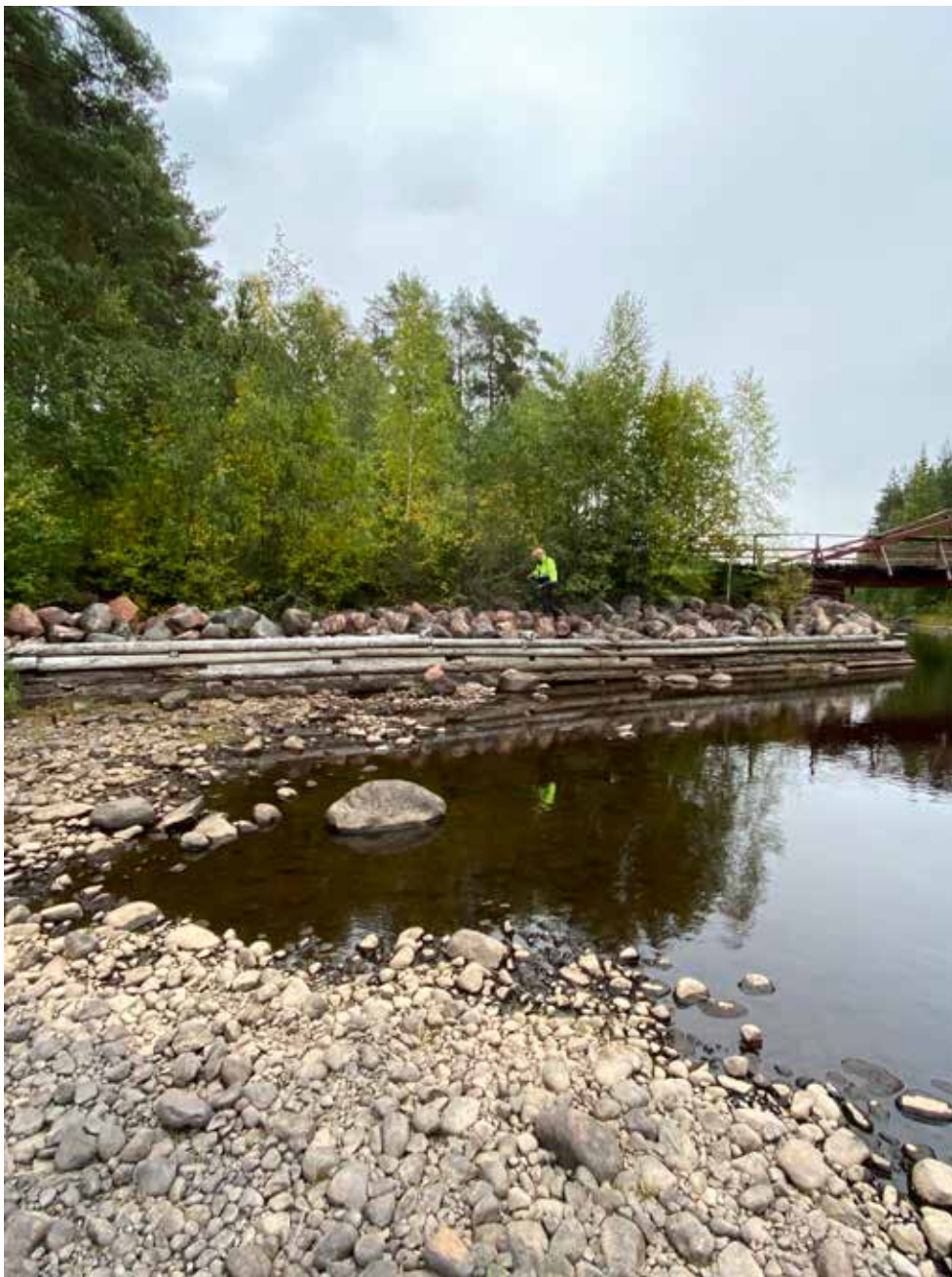
Lämning 24_9, L2020:9531. Stenkista, med synlig träkonstruktion, ca 25 m (NNV-SSÖ), 2 m br och 1,5 m h. Vid fältbesöket var 4 stockvarv synliga. Uppbyggd av 0,2–0,8 m st stenar. Avslutas i brofundament. Kulturvärde: Röd
