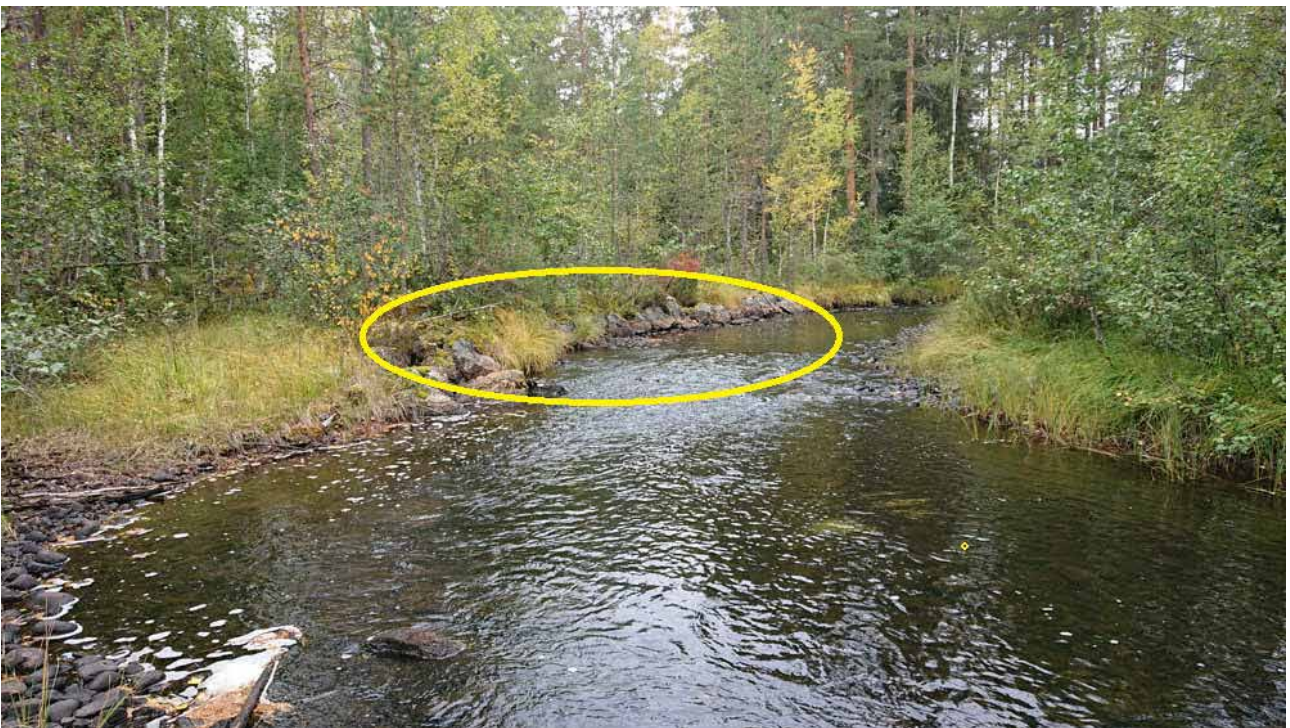
Lämning J2_1, L2020:9362. Strandskoning, utan synlig träkonstruktion, ca 30 m l (NNÖ-SSV), av 0,7–1 m st stenar. Beväxt med gräs och sly. Kulturvärde: Gul
