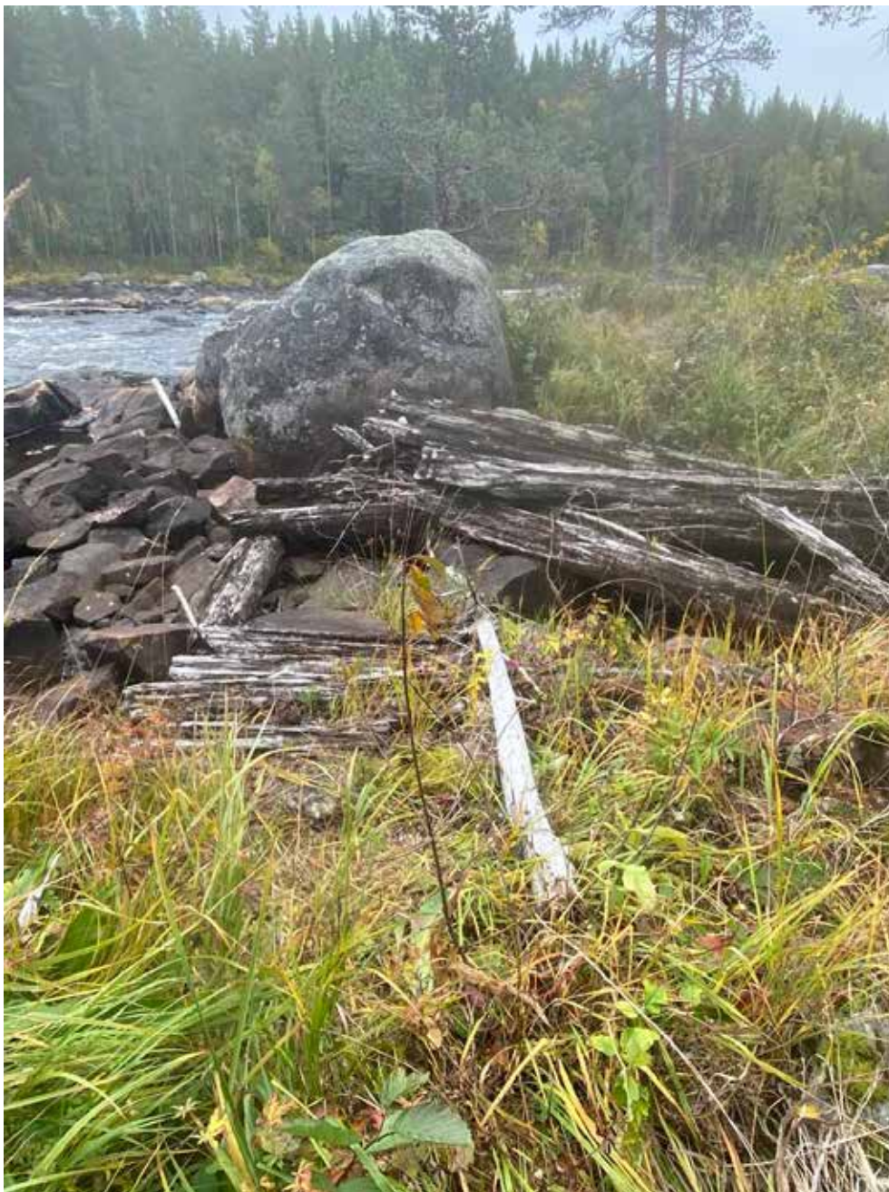
Lämning 11_1, L2020:9436. Stenkista, med synlig träkonstruktion, ca 80 m l (VNV-ÖSÖ), 3 m br och 0,5 m h. Vid fältbesöket var 1 stockvarv ställvis synligt. Uppbyggd av 0,2–0,8 m st stenar. Lämningen till stora delar raserad. Kulturvärde: Gul
