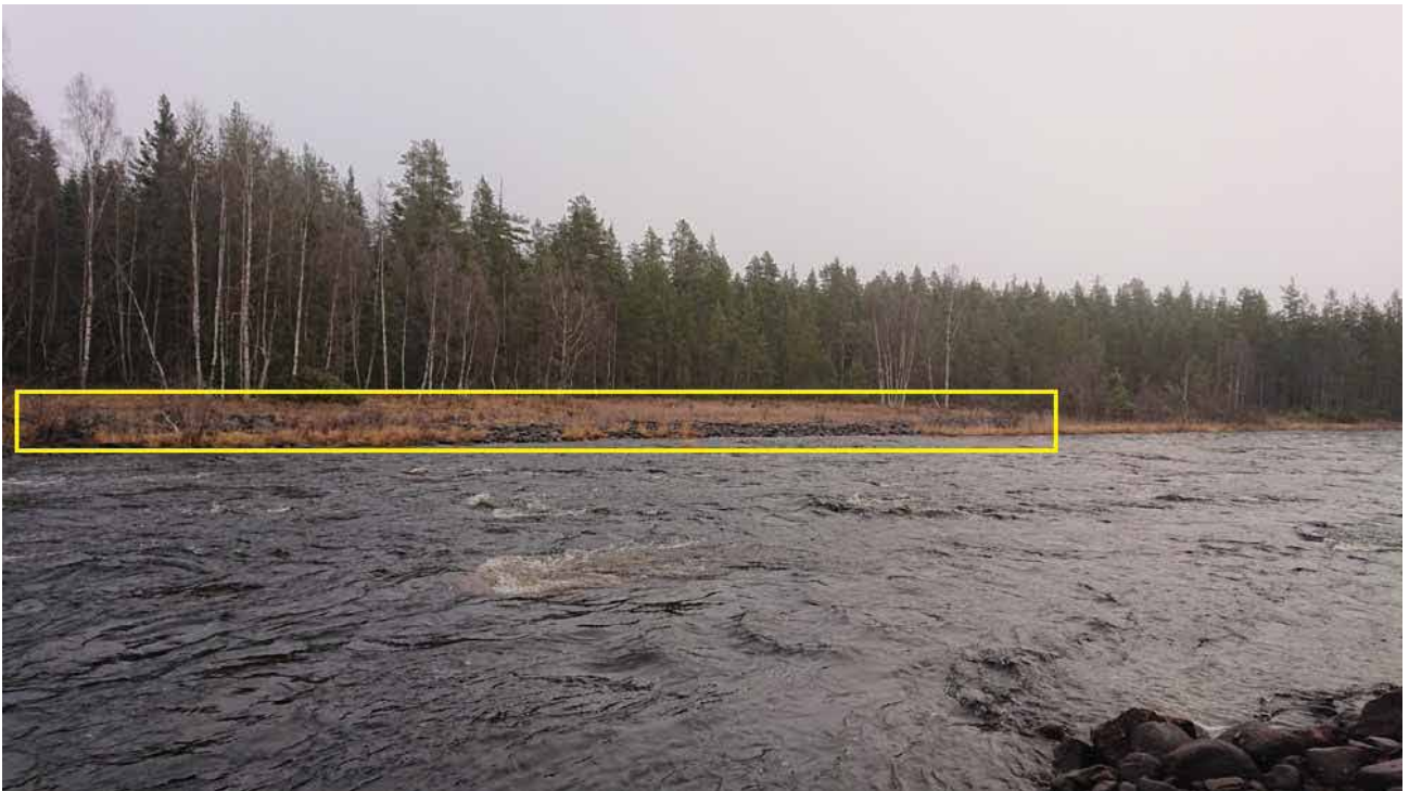
Lämning 13_111, L2020:11227. Ledarm, utan synlig träkonstruktion, ca 200 m l (NV-SÖ), 5-8 m br och 1-1,5 m h, av 0,3-1 m st stenar. Kulturvärde: Gul
