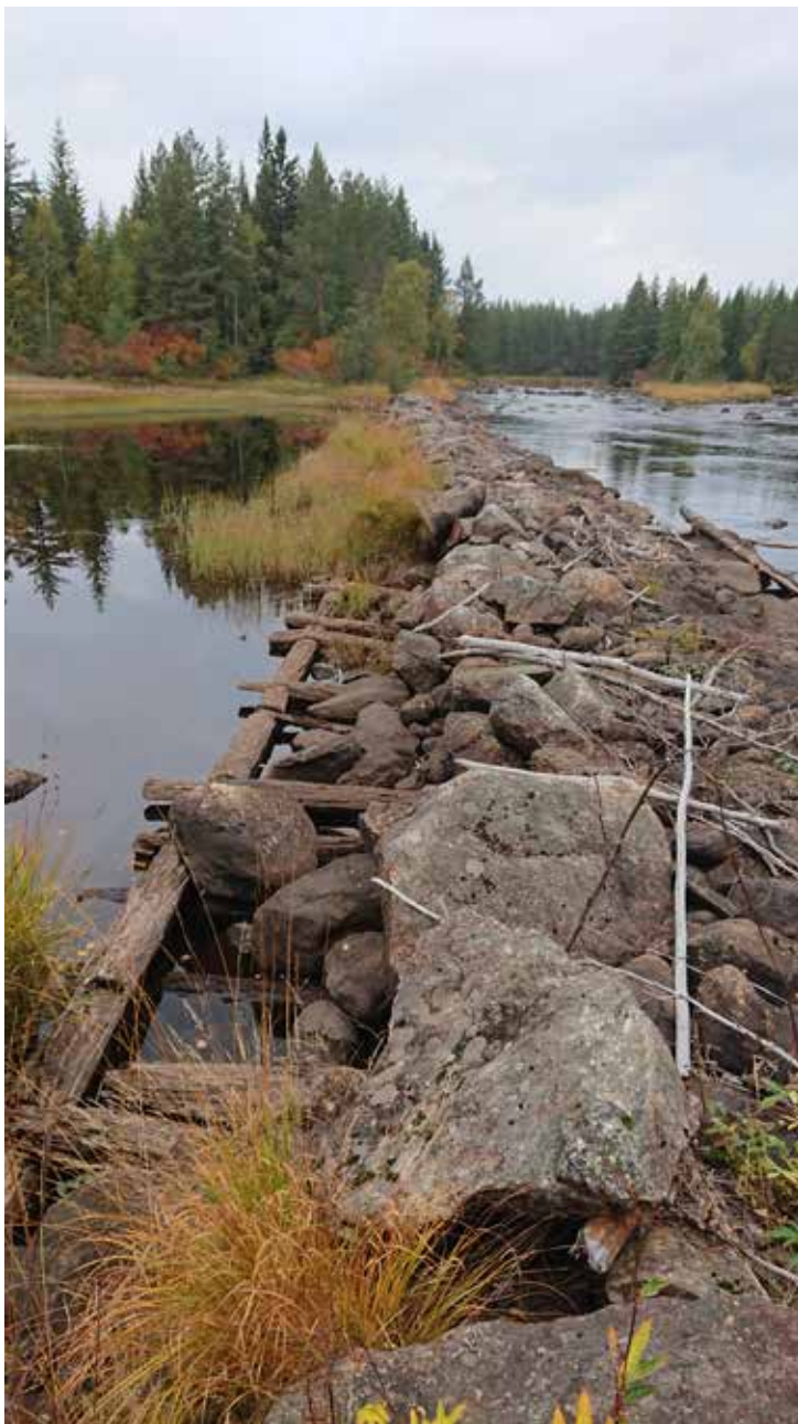
Lämning 23_1, L2020:9521. Ledarm, med ställvis synlig träkonstruktion, ca 110 m (NNV-SSÖ), ca 4 m br och 0,5 m h. Vid fältbesöket var 1–2 stockvarv synliga. Uppbyggd av 0,1–0,8 m st stenar. Stänger av biflöde till V. Delvis beväxt med gräs och sly. Kulturvärde: Röd
