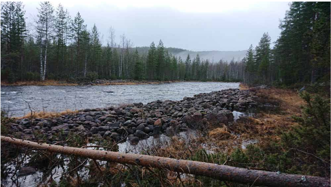
Lämning 9_126, L2020:11214. Strandskoning, utan synlig träkonstruktion, ca 130 m l (Ö-V), 4-6 m br och 0,6-1,5 m h, av 0,3-0,8 m st stenar. Kulturvärde: Gul
