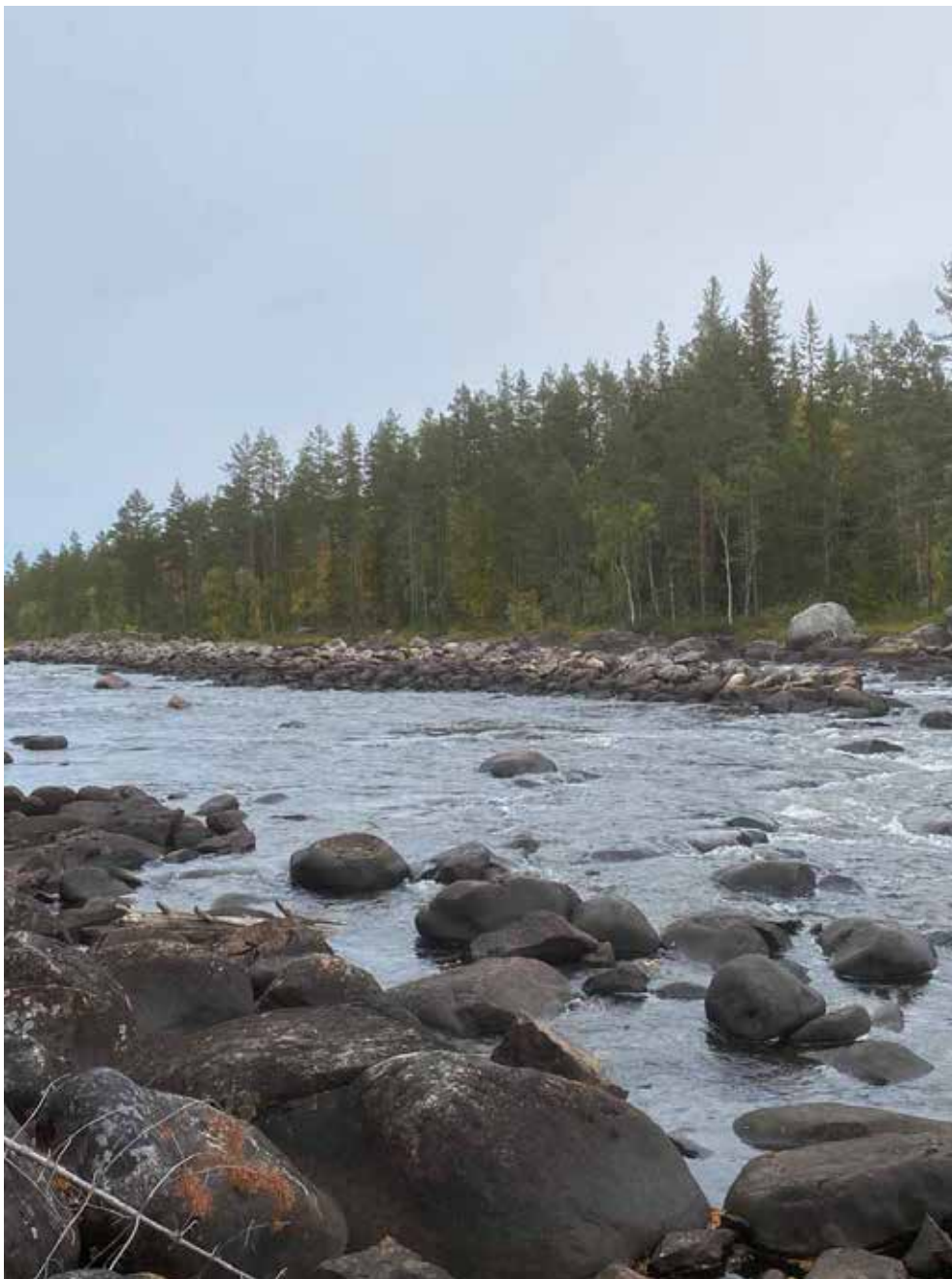
Lämning 11_2, L2020:9438. Ledarm, utan synlig träkonstruktion, ca 70 m l (N-S), ca 2–3 m br och 1–2 m h. Uppbyggd av 0,2–1,5 m st stenar. Den S delen utgörs av tätt lagd sprängsten. Kulturvärde: Gul
