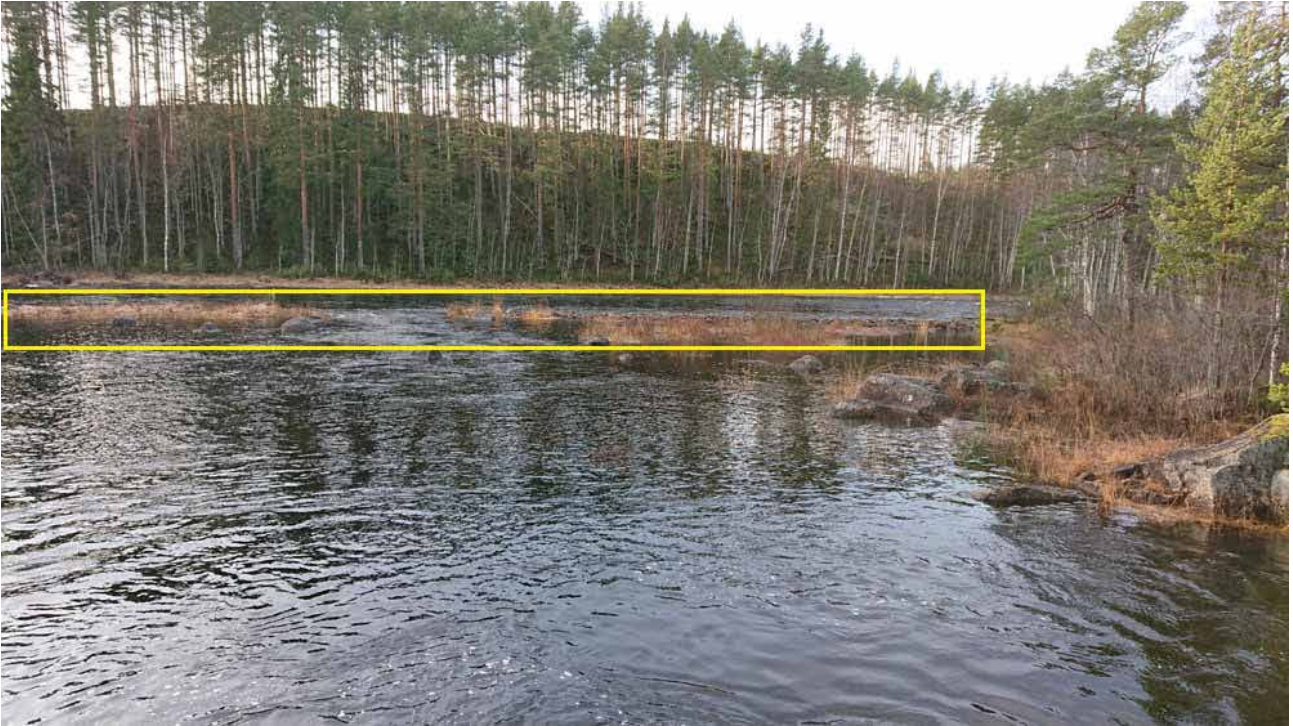
Lämning 20_100, L2020:11246. Ledarm, utan synlig träkonstruktion, ca 40 m l (NV-SÖ), 2-3 m br och 0,5-1 m h, av 0,3-0,8 m st sten. Kulturvärde: Gul
