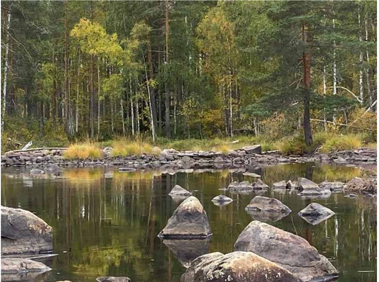
Lämning 19_5, L2020:9475. Stenkista, med synlig träkonstruktion, ca 30 m l (NV-SÖ), ca 4 m br och 0,5 m h. Vid fältbesöket var 1 stockvarv synligt. Uppbyggd av 0,3–0,5 m st stenar. Stänger av ett biflöde. Kulturvärde: Gul
