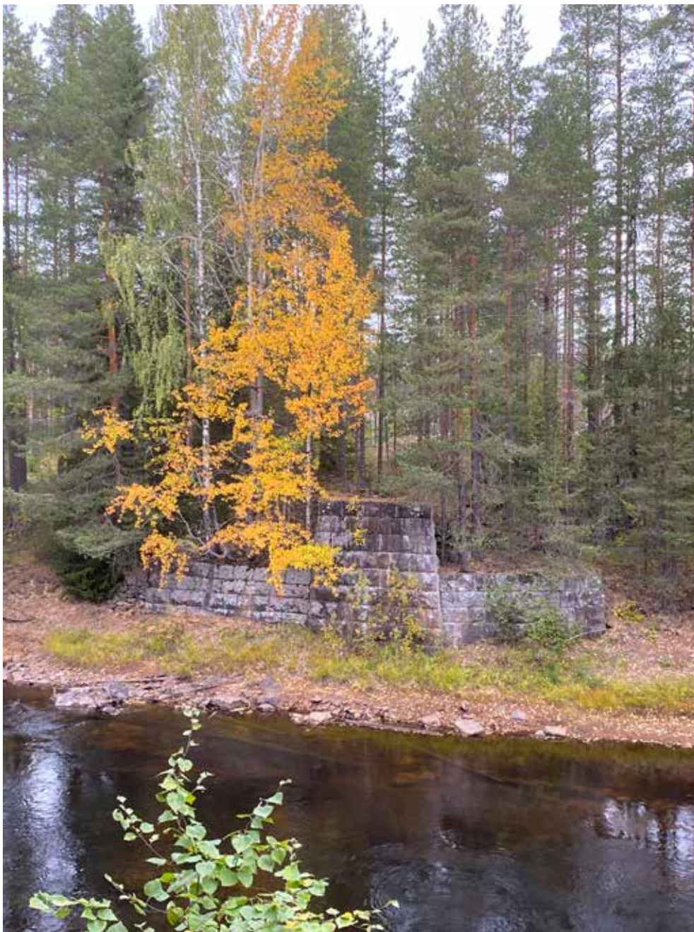
Lämning 24_8, L2020:9530. Brofundament, ca 20 m br och 5–8 m h, av huggna stenblock, ca 2x0,7 m. På ömse sidor av älven och ansluter på båda sidor till äldre vägbank. Kulturvärde: Gul
