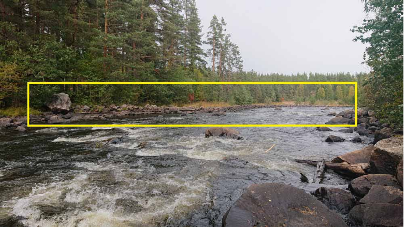
Lämning 24_7, L2020:9529. Strandskoning, ställvis med synlig träkonstruktion, ca 150 m l (Ö-V), av 0,4–1 m st stenar. Vid fältbesöket var 2 stockvarv synliga. Kulturvärde: Gul
