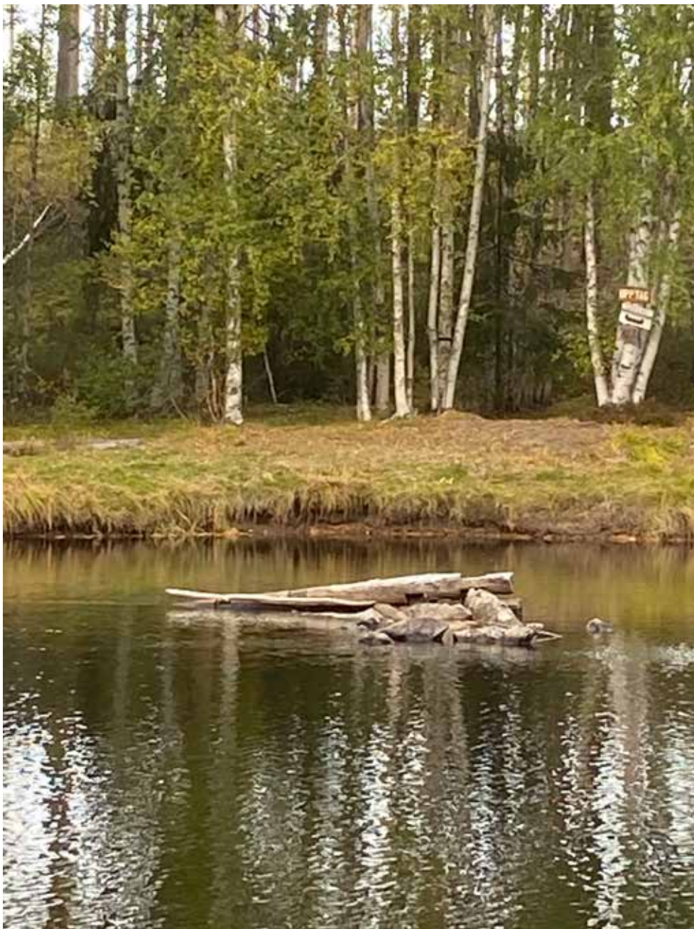
Lämning 24_2, L2020:9523. Stenkista, går ej att avgränsa pga högt vattenstånd. Endast de övre stenarna synliga, ca 0,3–0,4 m st. Två stockvarv delvis synliga. Kistan ligger ca 5 m ut från den N strandkanten. Kulturvärde: Gul
