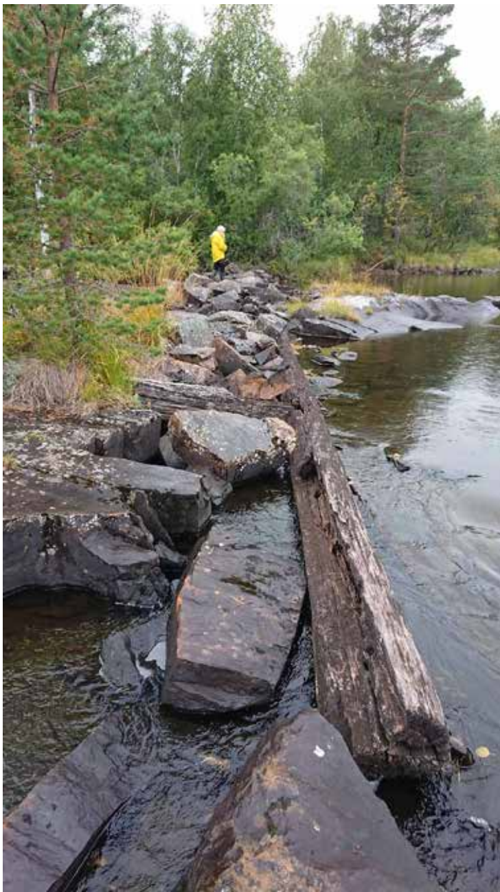
Lämning 3_2, L2020:9402. Strandskoning med synlig träkonstruktion, ca 20 m l (Ö-V), 2–3 m br och 0,3–0,6 m h. Uppbyggd av stenar, 0,3–1 m st. Delvis byggd på häll. Kulturvärde: Röd
