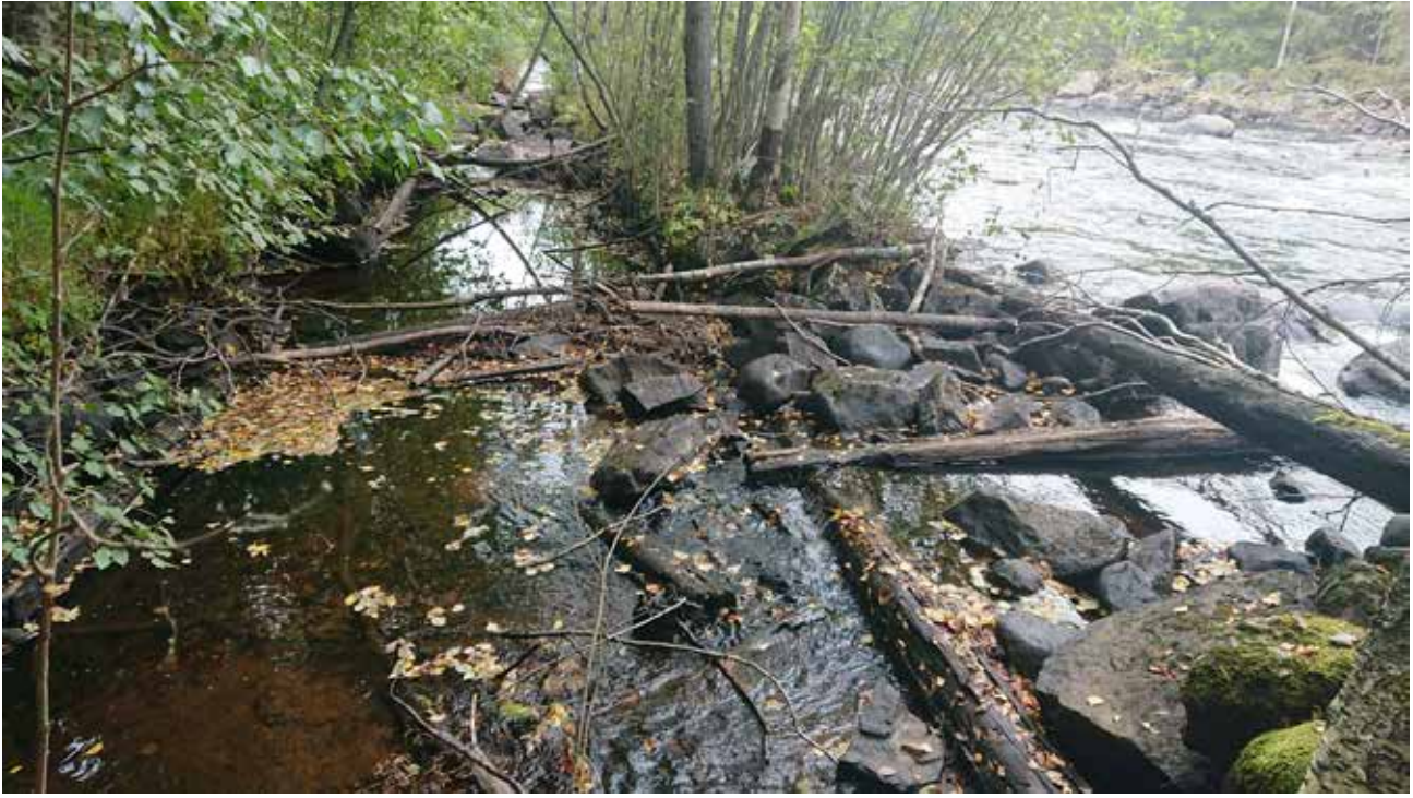
Lämning 26_2, L2020:9534. Ledarm, med synlig träkonstruktion, 40 m l (NNÖ-SSV), 2,5–3 m br och 0,2–0,4 m h. Vid fältbesöket 1–2 stockvarv synliga. Uppbyggd av 0,2–0,5 m st stenar, även markfasta block ingår. Mellan ledarmen och stranden, flötningsränna ca 3 m br och 0,5 m dj, med timmerskoning i NÖ och SV delen. Ledarmen beväxt med sly. Kulturvärde: Röd
