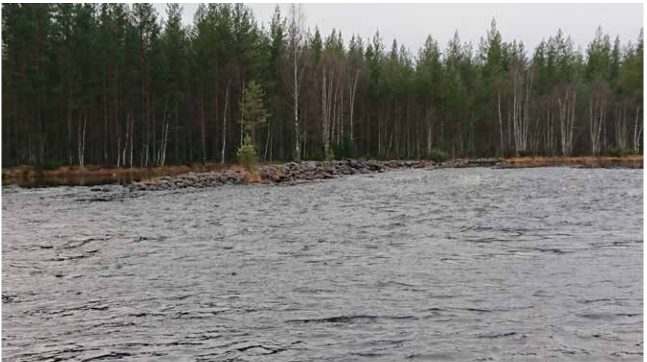
Lämning 19_123, L2020:11245. Ledarm, utan synlig träkonstruktion, ca 70 m l (Ö-V), 3-4 m br och 0,6-1,2 m h, av 0,4-1 m st stenar. Kulturvärde: Gul
