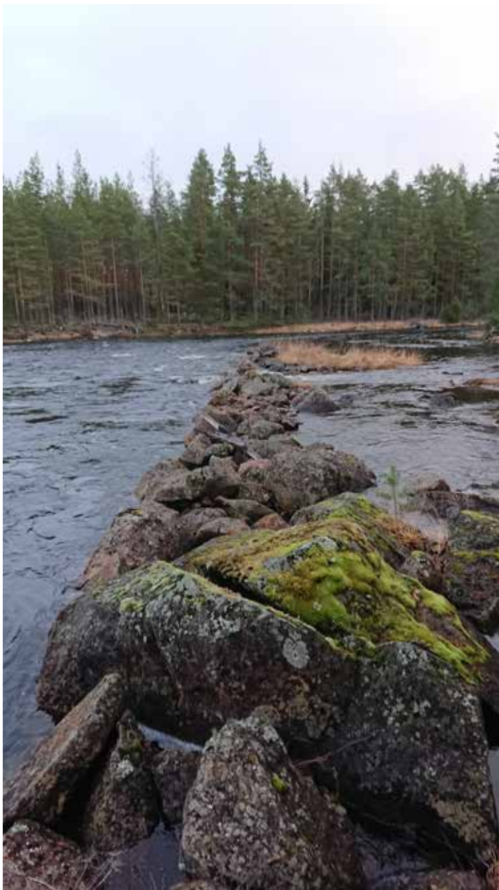
Lämning 22_130, L2020:11249. Ledarm, utan synlig träkonstruktion, ca 45 m l (NÖ-SV), 2-4 m br och 0,6-1 h, av 0,4-0,8 m st stenar. Delvis raserad. Öppning i S delen. Kulturvärde: Gul
