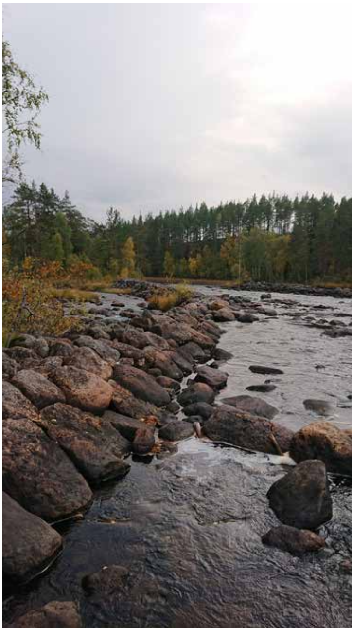
Lämning 20_8, L2020:9518. Ledarm, bågformad, ca 90 m l (N-S), 4–5 m br och 0,8 m h, av 0,3–1 m st stenar. Ställvis vällagd. Centrala delen är raserad där vatten forsar igenom. Kulturvärde: Gul
