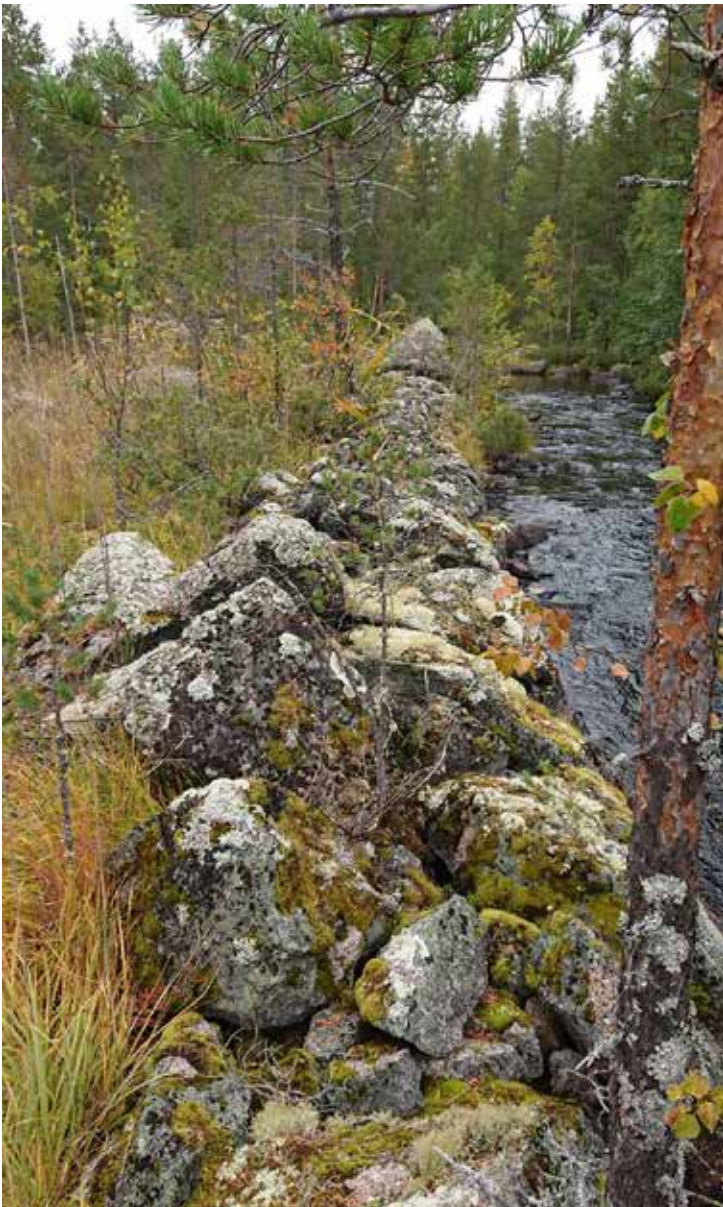
Lämning J1_4, L2020:9353. Strandskoning, utan synlig träkonstruktion, ca 20 m l (NV-SÖ), 3 m br och 0,5–1,5 m h, av 0,5–1 m st stenar. Vällagd med sluttande yta mot älven. På lämningen upplagd renssten. Beväxt med enstaka lövsly. Kulturvärde: Röd
