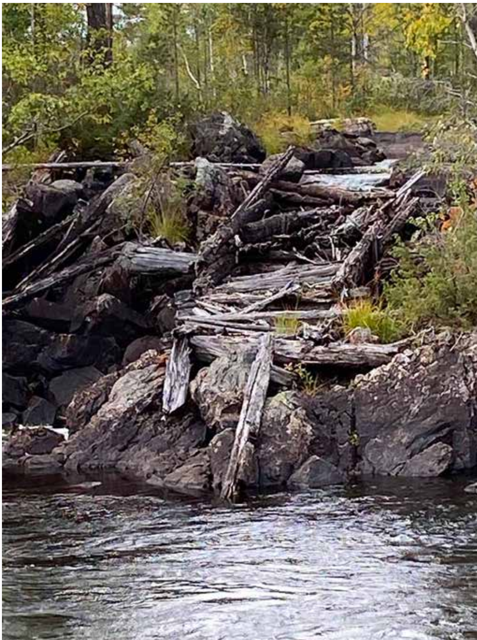
Lämning 2_4, L2020:9395. Flottningsränna, raserad, 20 m l (NV-SÖ) och 2 m br, av timmer i 4 stockvarv. Stockar från rännan finns i närområdet. Kulturvärde: Röd
